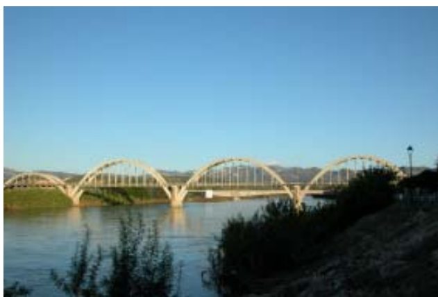
Figura 6.17. El pont que uneix les dues Mores sobre el riu Ebre, per les seves formes, es una singularitat a la que se li reconeix un valor estètic.
