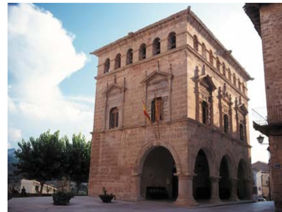
Figura 4.7. Vista de l'edifici renaixentista on actualment hi ha la seu de l'Ajuntament d'Arnes.
