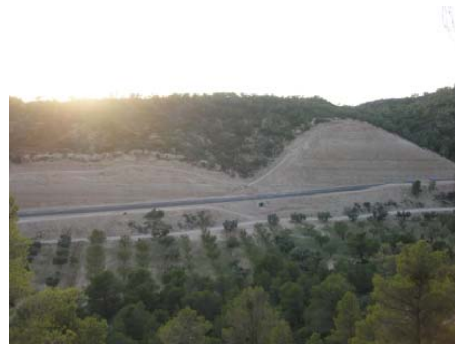
Figura 4.26. Impacte provocat pels talussos de l'arranjament de la carretera C-221 al seu pas per les Riberes de l'Algars.
