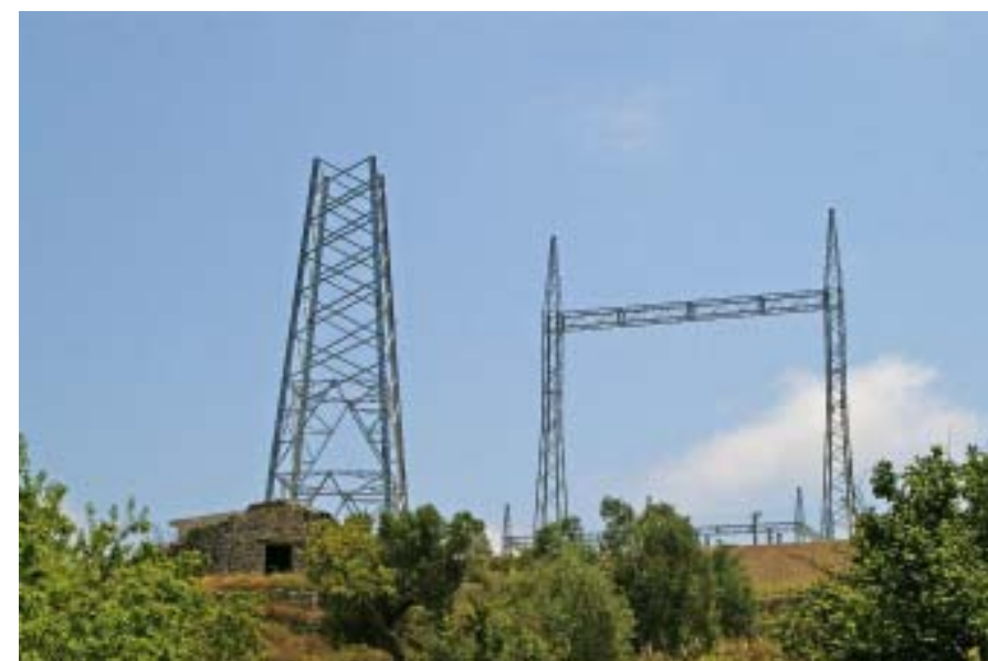
Figura 2.21. Construcció d'una torre i una subestació elèctrica prop de La Fatarella.
