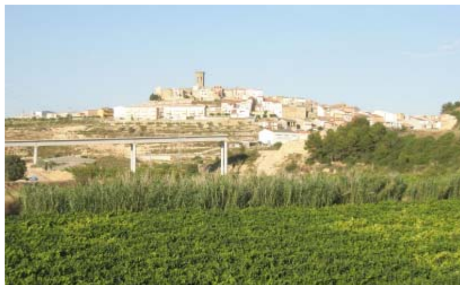
Figura 2.22. Obres de construcció d'un viaducte a la variant de Batea de la C-221.
