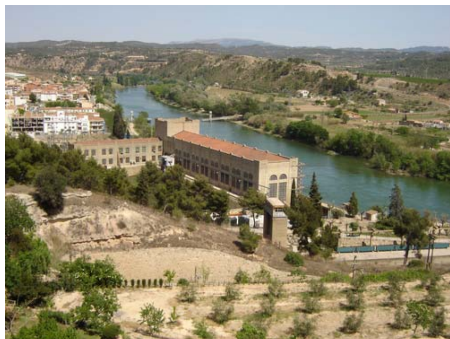
Figura 1.8. Nucli urbà de Flix i tram final del meandre, amb l'edifici de la central hidroelèctrica en primer terme.
