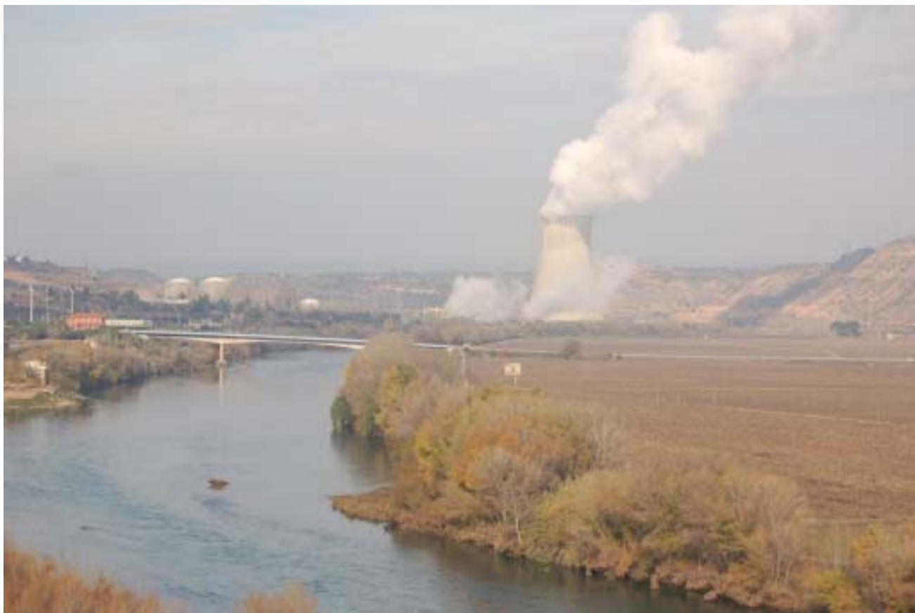
Figura 1.2. Torre de refrigeració i complex nuclear d'Ascó.
