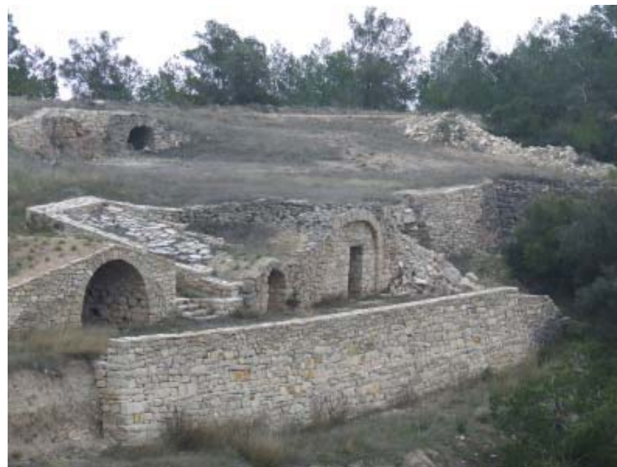
Figura 1.11. Conjunt d'arquitectura rural de pedra seca, a la capçalera d'un dels fondos de la Fatarella.
