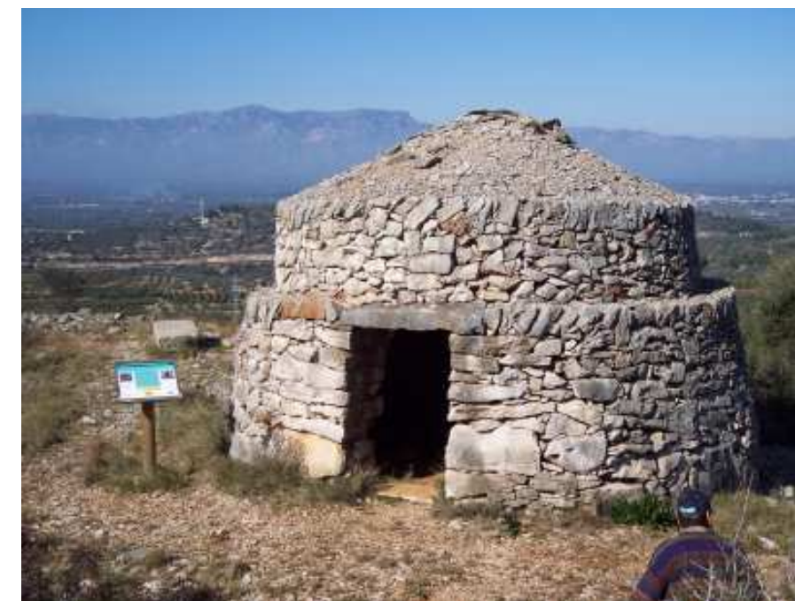
Figura 18.22. Barraca de Quicolis. Element amb valor històric construït en la tècnica de la pedra en sec.
