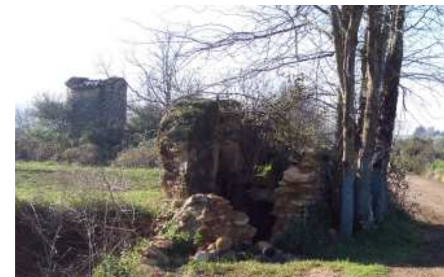
Figura 18.34. Patrimoni rural construït a la Foia d'Ulldecona, en clar procés de deteriorament.
