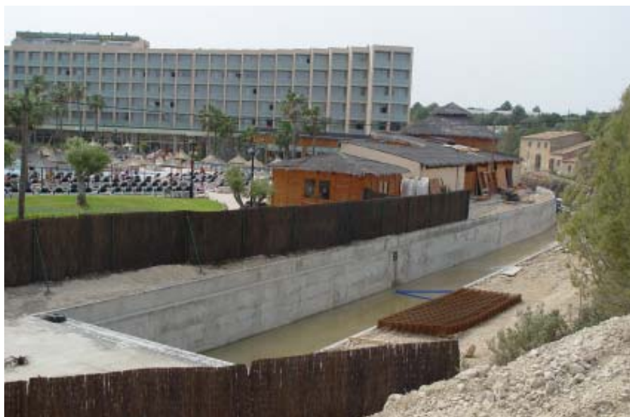
Figura 17.31. Canalització d'una riera just a la seva desembocadura.
