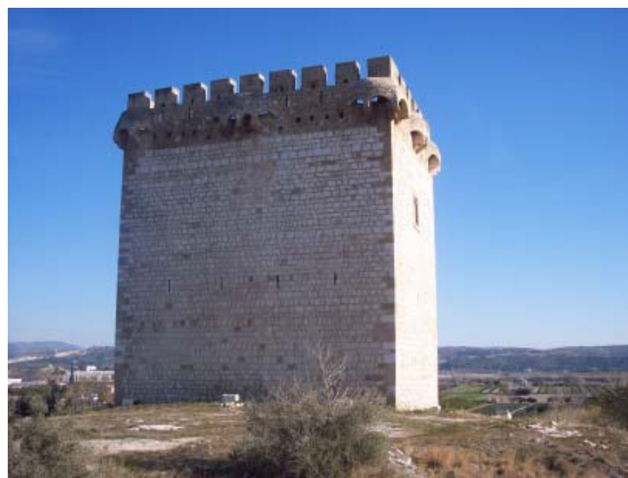
Figura 15.26. Torre de la Carrova. Al fons, les primeres terrasses al·luvials del riu Ebre.
