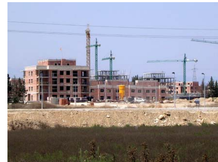
Figura 15.29. Obres d'urbanització i primers edificis de la nova taca urbana del terme municipal de l'Aldea, a la vora del riu Ebre i disgregada del nucli urbà actual.
