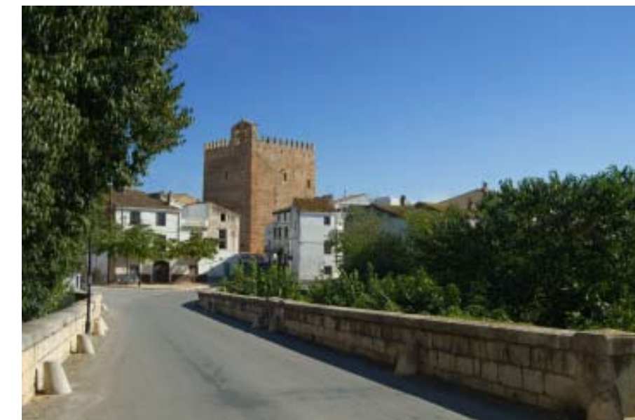
Figura 14.20. Pont que creua el barranc de la Galera. Limit entre els municipis d'Ulldecona, al sud i Tortosa, al nord. En aquesta imatge també s'hi observa la torre de defensa de la Galera.
