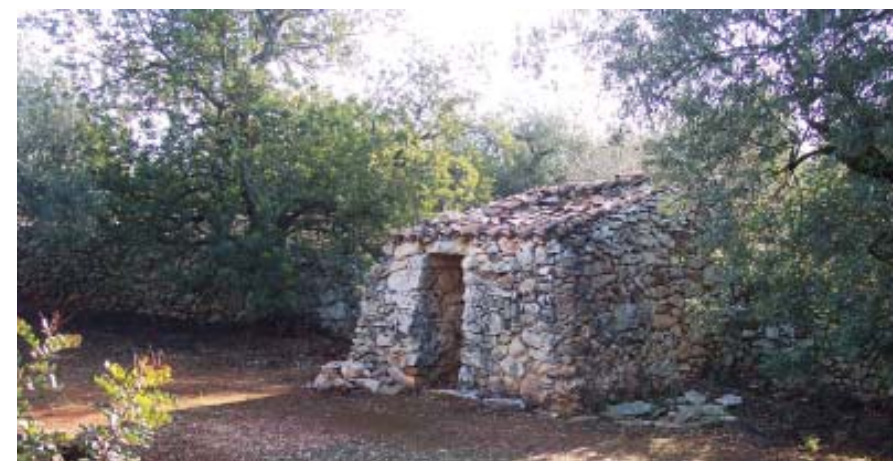
Figura 14.34. Caseta construïda amb la tècnica de la pedra en sec. Aquest element, amb el seu entorn, són exemples de l'elevat patrimoni històric, rural i agrícola d'aquestes planes.
