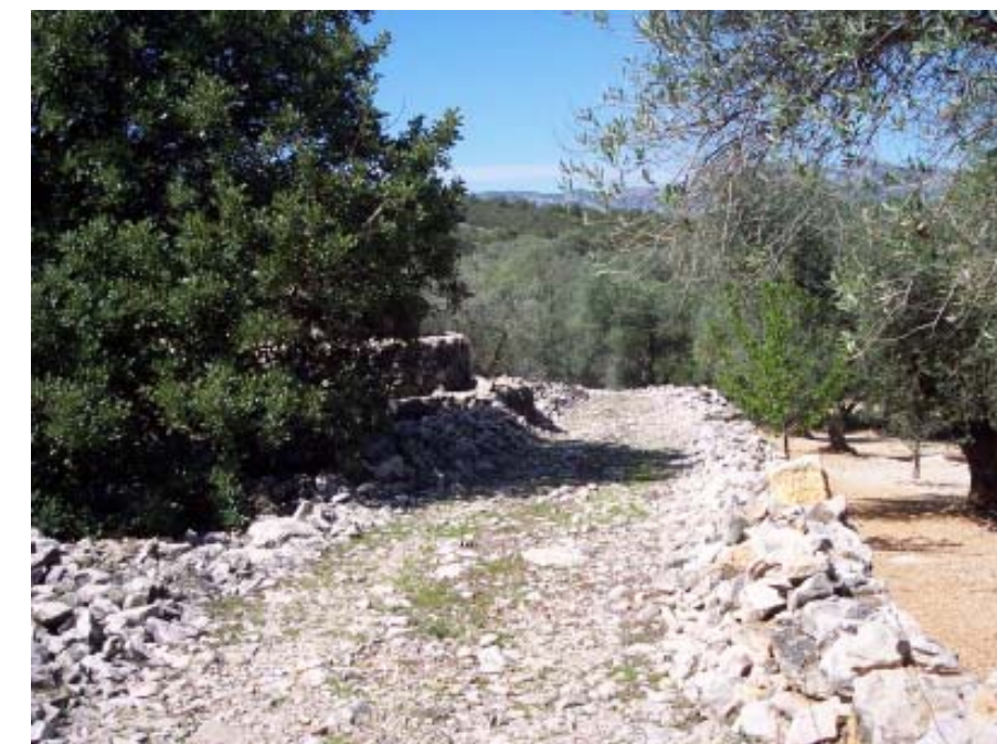
Figura 14.24. Camí d'accés a una finca d'oliveres realitzat amb pedra en sec.
