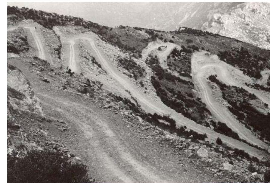
Figura 13.22. Pujada al Port des de Carreretes. Obres del nou camí, actualment única pista forestal dels Ports asfaltada.
