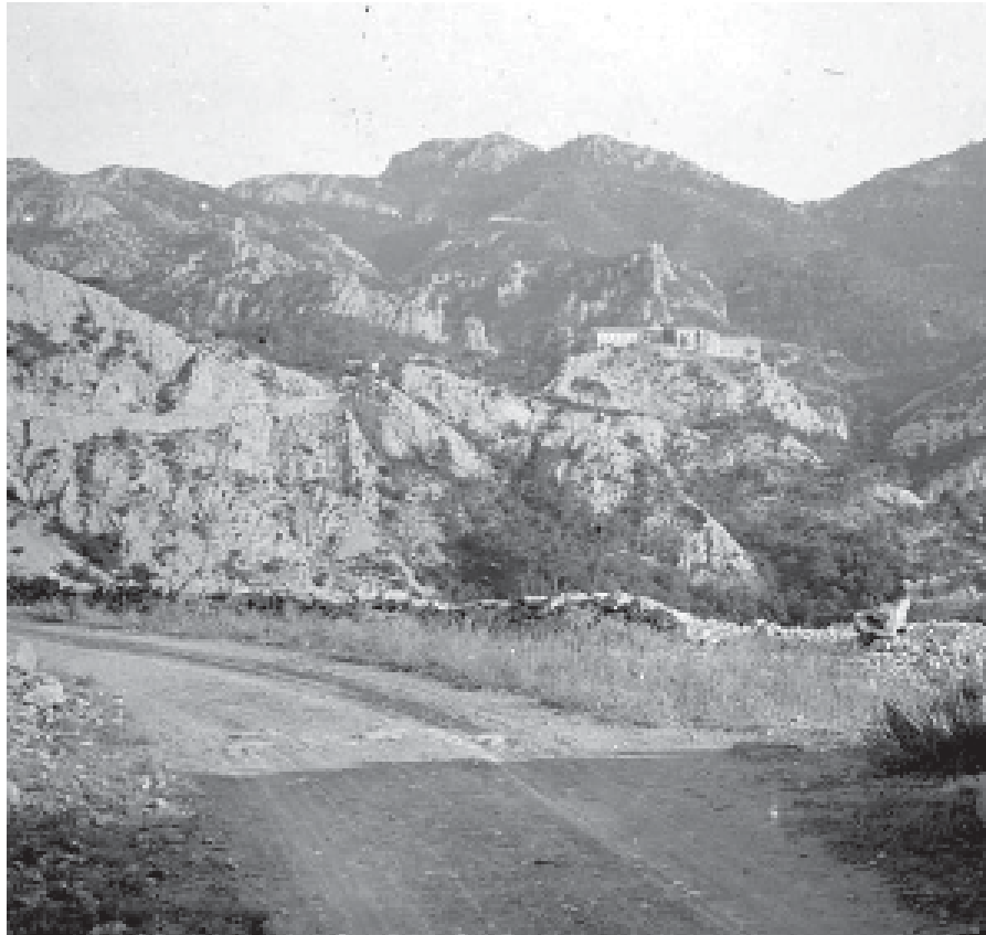
Figura 12.10. Balneari de Cardó i el seu entorn. Imatges preses al 1914 (Font: Fons fotogràfics Cuyàs i Salvany) i al 2004
