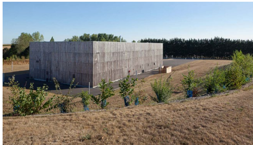
Sala de espectáculos. Ostaderia (FR). GLV architectes. http://www.glvarchitectes.com
