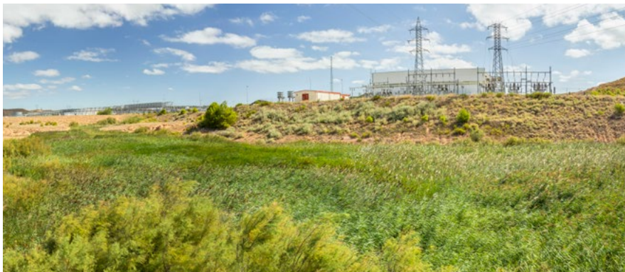
Embalse laminador de aguas pluviales ubicado en el extremo suroeste. Fotografía: Bakartxo Aniz Aldasoro
