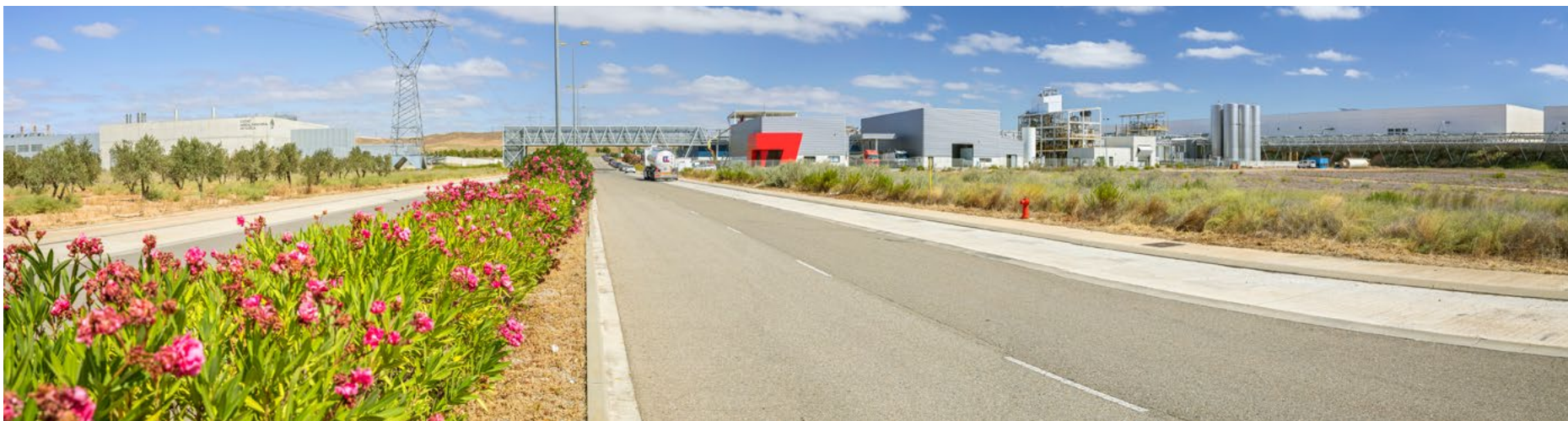
Vista del área de actividad económica, al fondo la infraestructura técnica (rack aéreo). Fotografía: Bakartxo Aniz Aldasoro
