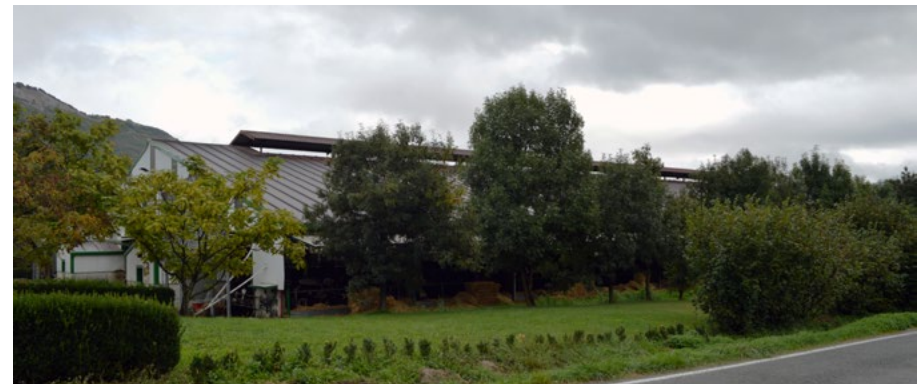
Nave en Etxeberri, Arakil. Adecuado tratamiento de vegetación.
