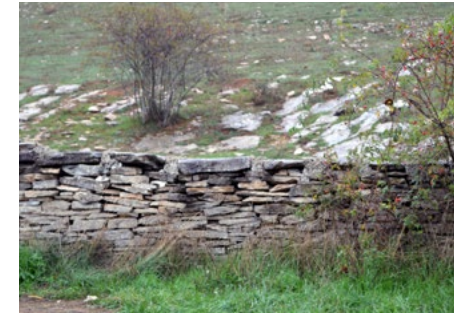
Vallado tradicional de muro de piedra seca en Lezaun
