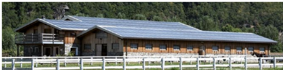
Picadero con instalación fotovoltaica en cubierta, bien integrada.
