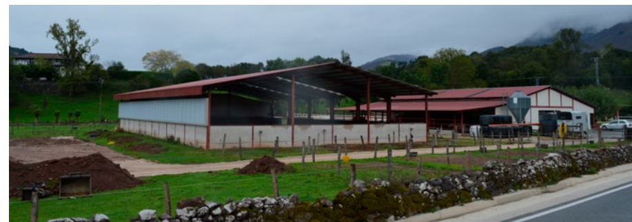
Mantenimiento de vallado tradicional, en piedra seca, en una granja contemporánea en Baztan.
