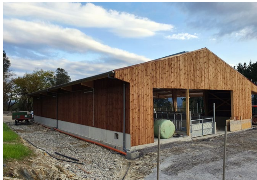
Nave ganadera en Larrabetzu, Bizkaia. Utilización de materiales sostenibles. Fotografía: Teresa Garagalza Muñoz.
