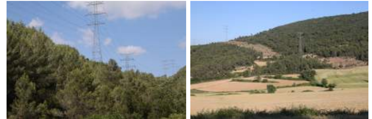
Fotos. Línies elèctriques al seu pas per la zona de l'Alt Gaià; a la dreta es pot observar l'impacte visual causat per les franges de protecció
