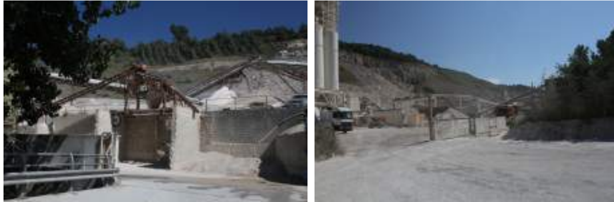
Fotos. Dues vistes de les instal·lacions de la pedrera de Viladerdius
