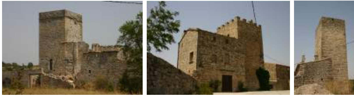
Fotos. Tres exemples de torres medievals al voltant de les quals es van constituir pobles i llogarrets, totes elles al terme de Passanant i Belltall; respectivament, la Sala de Comalats, Ferran i Segura
