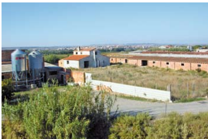
Granges a les proximitats de Torres de Segre, al sud del Paisatge fluvial del Segre. Observatori del Paisatge
