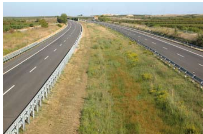
Autopista AP-2 a les proximitats de Torres de Segre. Observatori del Paisatge
