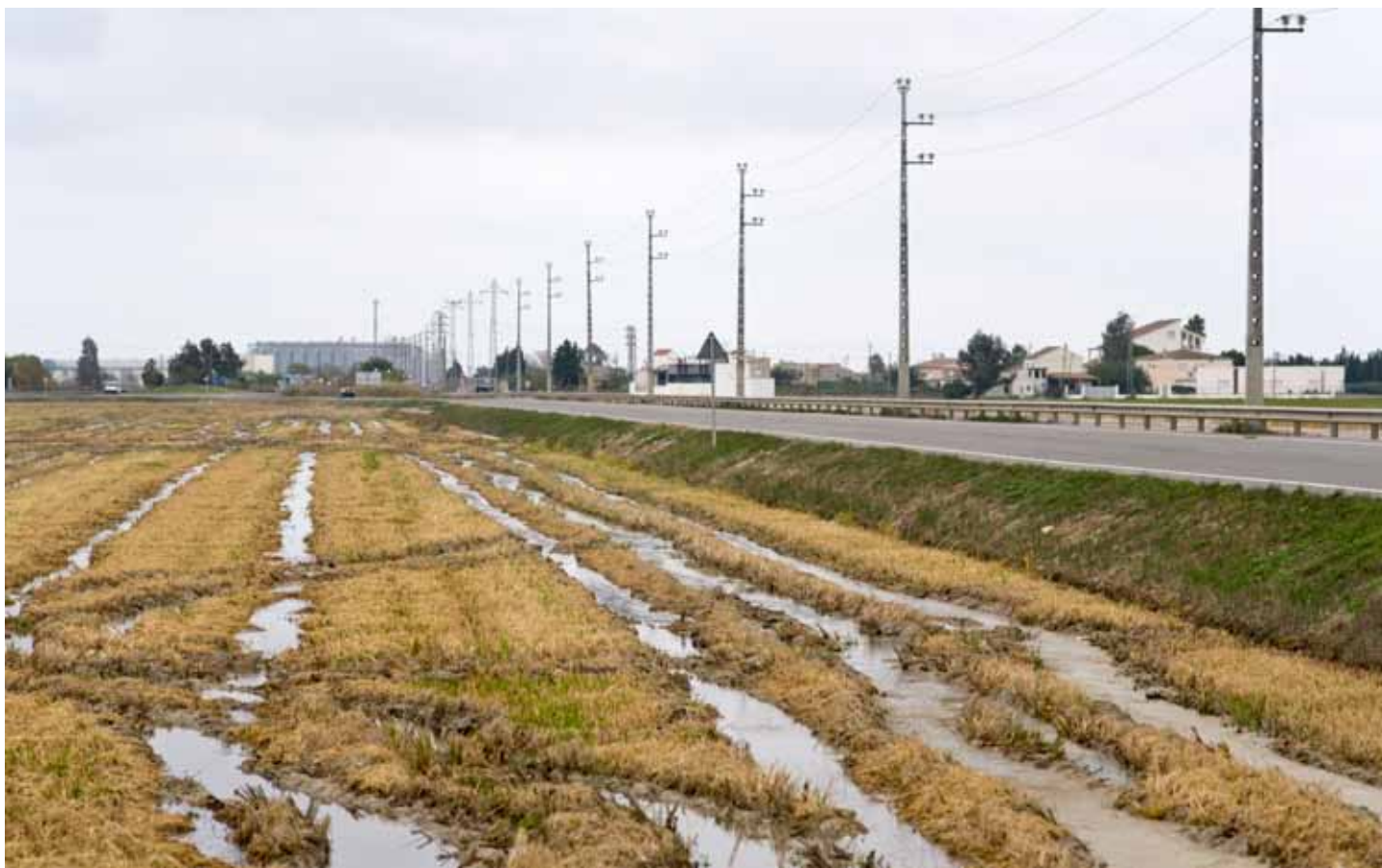
Algunes línies elèctriques aprofiten el traçat de les carreteres ja existents. Lluís Vives, Escola d'Art i Disseny de Tarragona
