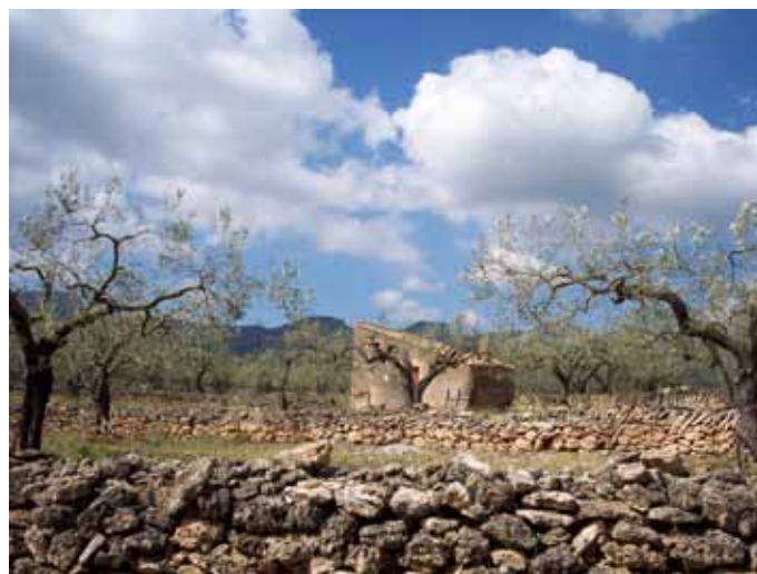
A les explotacions agrícoles més allunyades dels pobles, és més habitual trobar les anomenades "casetes", construccions de pedra i morter amb teulada d'una sola vessant. Observatori del Paisatge
