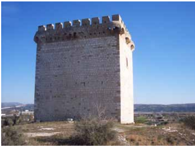
La torre de la Carrova, situada al costat de la carretera C-12 i del canal de la Dreta de l'Ebre, és una de les construccions defensives més destacades de les Terres de l'Ebre. Observatori del Paisatge
