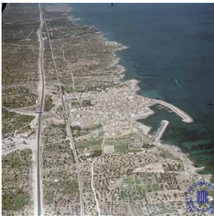
El litoral del Baix Ebre fou un dels paisatges on tingué més incidència la construcció de l'autopista AP-7, com es pot apreciar en aquesta imatge del procés de construcció. ICC, Fons SACE
