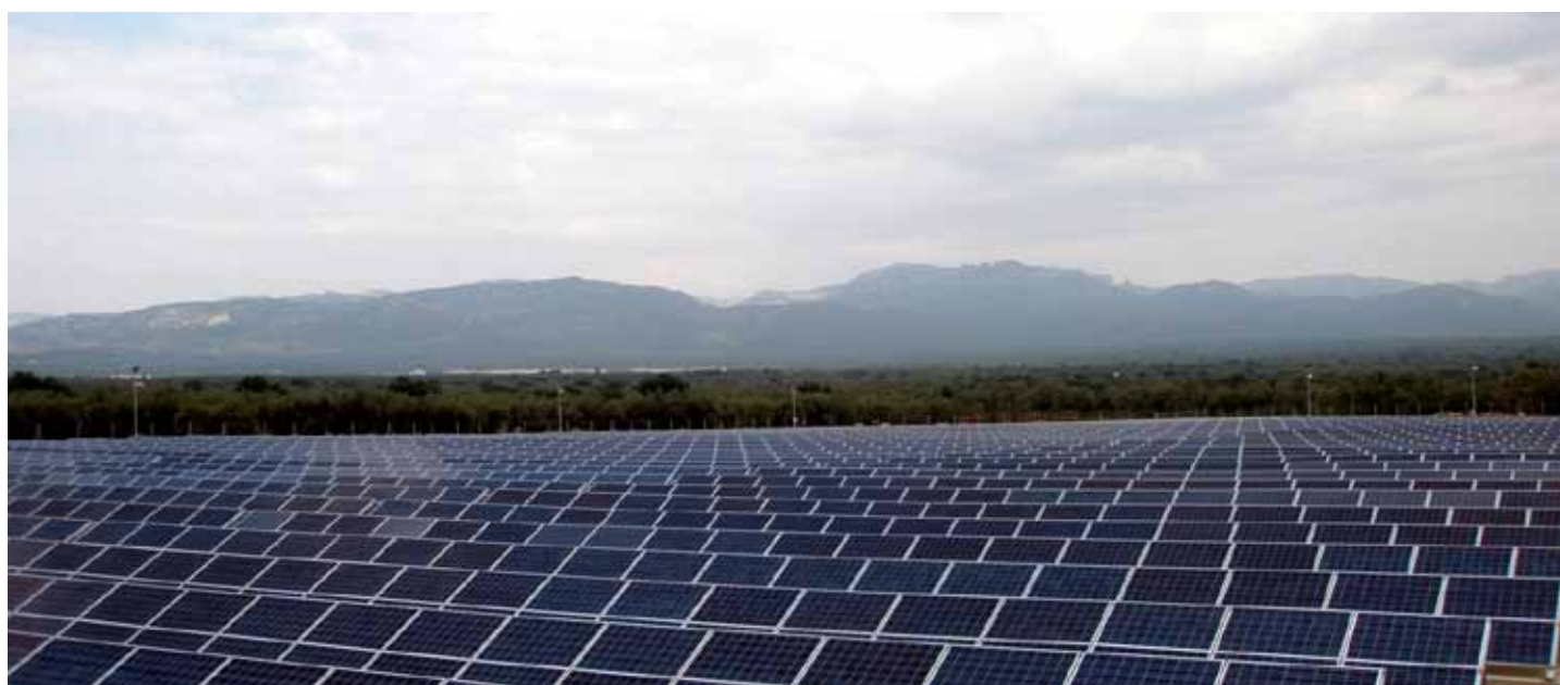
Parc fotovoltaic al barri dels Valentins, al municipi d'Ulldecona. Observatori del Paisatge
