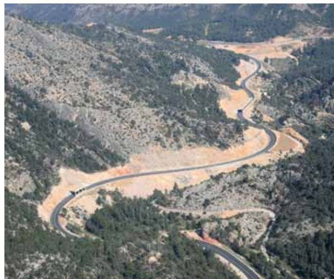
Durant l'ampliació de la carretera T-333, que uneix l'eix de l'Ebre amb la Terra Alta es va generar un gran nombre de talussos. Departament de Territori i Sostenibilitat
