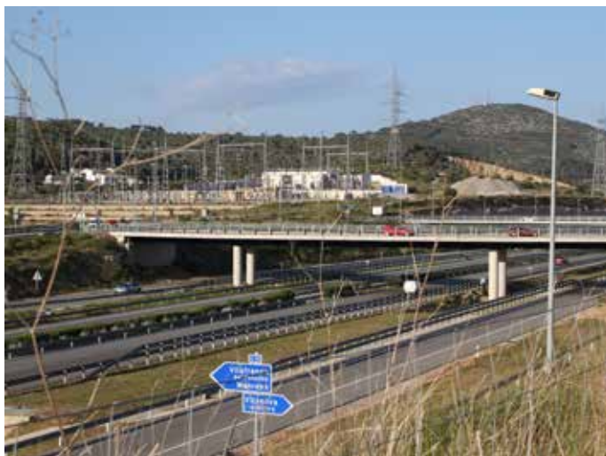
Zona d'enllaç entre la C-32 i la C-15 on s'hi concentren, a més de les carreteres, transformadors elèctrics, torres elèctriques i activitats extractives. Eduardo Soler, Limonium
