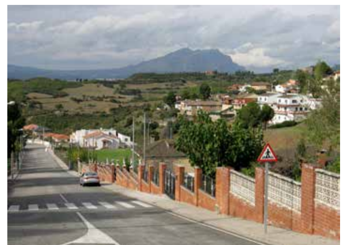
Les urbanitzacions residencials són el principal impacte sobre el territori d'aquesta unitat. Vista d'una urbanització al municipi de Castellbisbal. Observatori del Paisatge
