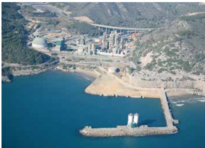
El complex industrial de Vallcarca, amb les seves centenàries instal·lacions i el seu petit port, constitueix una referència paisatgística. Departament de Territori i Sostenibilitat
