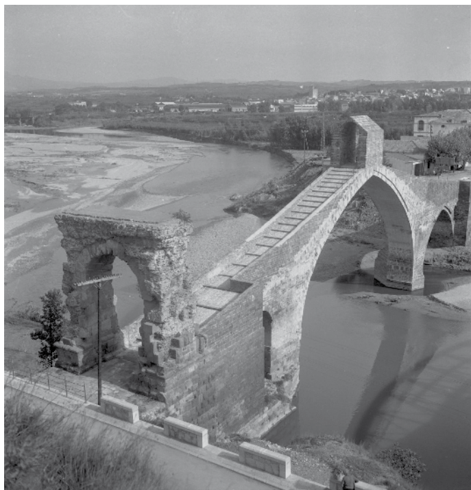
El pont del Diable de Martorell és d'origen romà (segle X aC) i formava part de la via Augusta. Del pont original es conserven els estreps i un arc triomfal al marge esquerre, la resta és fruit de diverses reconstruccions al llarg de la història. ICGC, Fons Cuyàs
