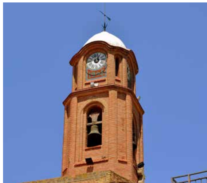
Campanar modernista de l'església parroquial de Santa Maria d'Ullastrell, obra de l'arquitecte terrassenc Lluís Muncunill. Àngela Llop
