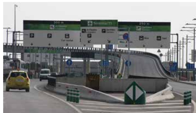
La construcció d'infraestructures ha transformat considerablement el paisatge del Delta del Llobregat. Ramon Vilalta, Departament de Territori i Sostenibilitat
