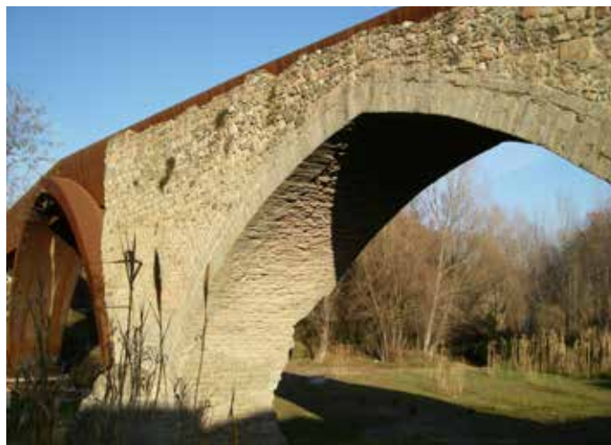
El pont trencat sobre la Tordera al seu pas per Sant Celoni és un dels elements amb valor simbòlic i identitari del Baix Montseny. Observatori del Paisatge
