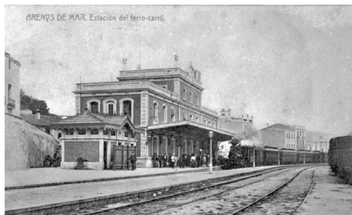
La construcció a mitjans del segle XIX del traçat del ferrocarril Barcelona - Mataró - Maçanet Massanes va afavorir grans canvis en el paisatge de la unitat. ICGC, Fons Cuyàs
