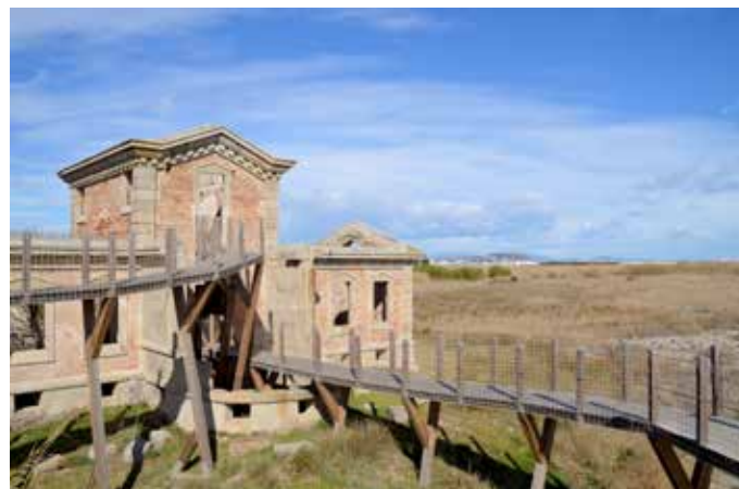
El Semàfor actualment forma part dels miradors dels Espais Naturals del Delta del Llobregat. Observatori del Paisatge
