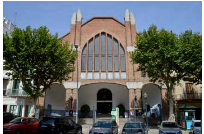
El mercat de Arenys és un edifici modernista d'Ignasi Mas i Morell, edificat entre 1911 i 1929. Observatori del Paisatge
