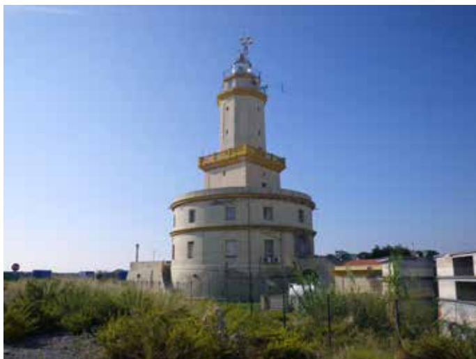
Far construït el segle XIX a 300 m del mar i a tocar de la desembocadura del Llobregat. Actualment es troba a pocs metres del mar però lluny del Llobregat, fet que evidencia tant el retrocés del Delta com la desviació del riu Llobregat. Pere Borràs i Garcia
