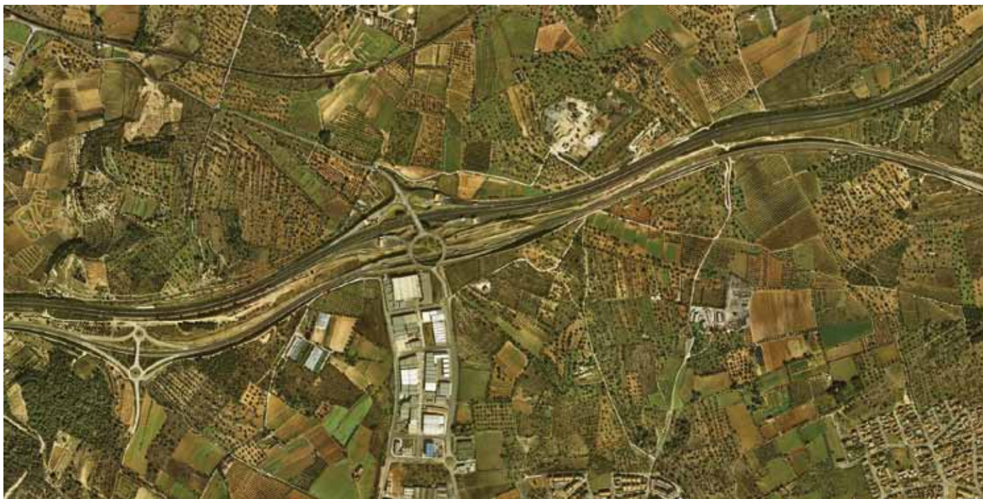
Pas de l'autopista AP-7 i l'autovia A-7 a l'alçada de Torredembarra. També es pot observar un polígon industrial associat a aquestes infraestructures viàries. ICC
