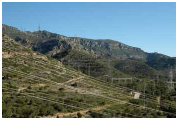
La necessitat d'evacuar l'energia generada a les centrals nuclears implica la presència de diverses línies elèctriques, que es concentren sobretot al sector sud de les muntanyes de Tivissa-Vandellòs. Observatori del Paisatge
