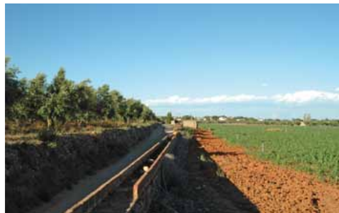
La majoria dels canals de reg que distribueixen l'aigua procedent de les mines es troben en mal estat, tot i que algunes de les mines encara es mantenen actives. Observatori del Paisatge
