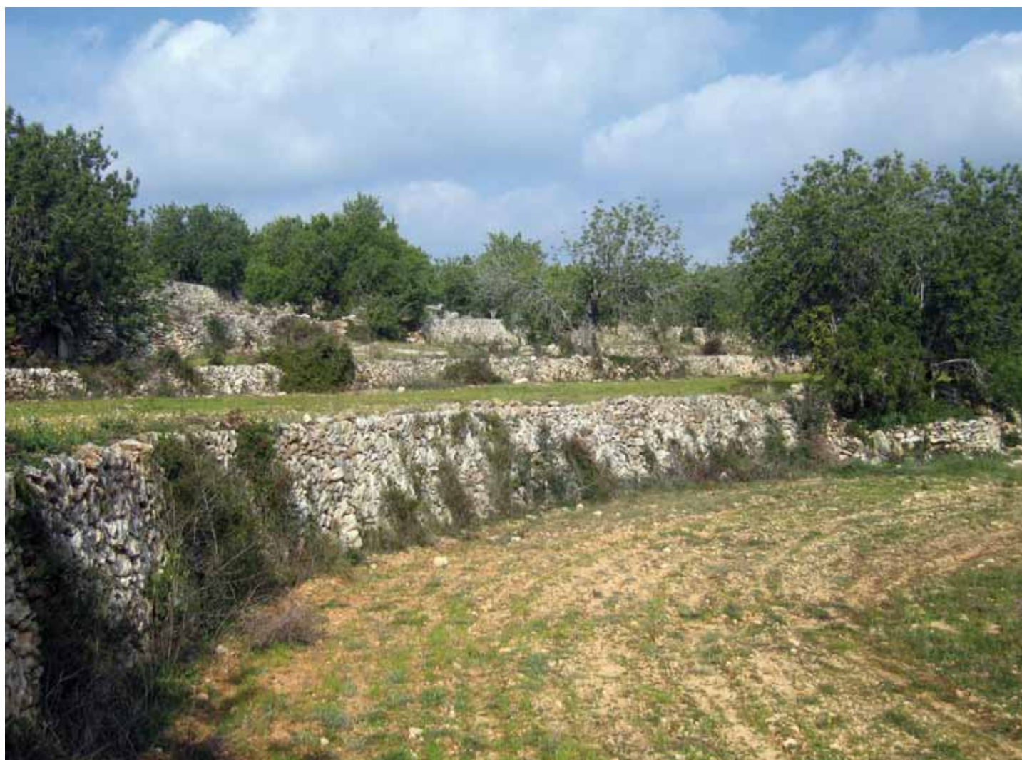
Camps de garrofers al nord de Torredembarra. L'esglaonat dels camps en feixes i la construcció dels murs amb pedres que s'extreuen de la superfície dels camps al llaurar constitueixen un dels elements més característics del paisatge agrícola mediterrani de secà. Observatori del Paisatge
