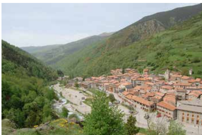
Nucli de Setcases, patró d'assentament de muntanya pirinenca, concretament dins el grup de nuclis amb coberta de teula. Observatori del Paisatge
