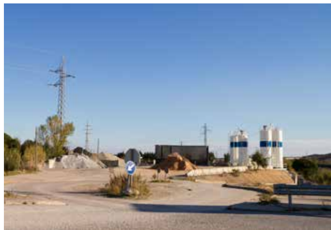
Activitat extractiva d'àrids al marge de la Tordera. Observatori del Paisatge
