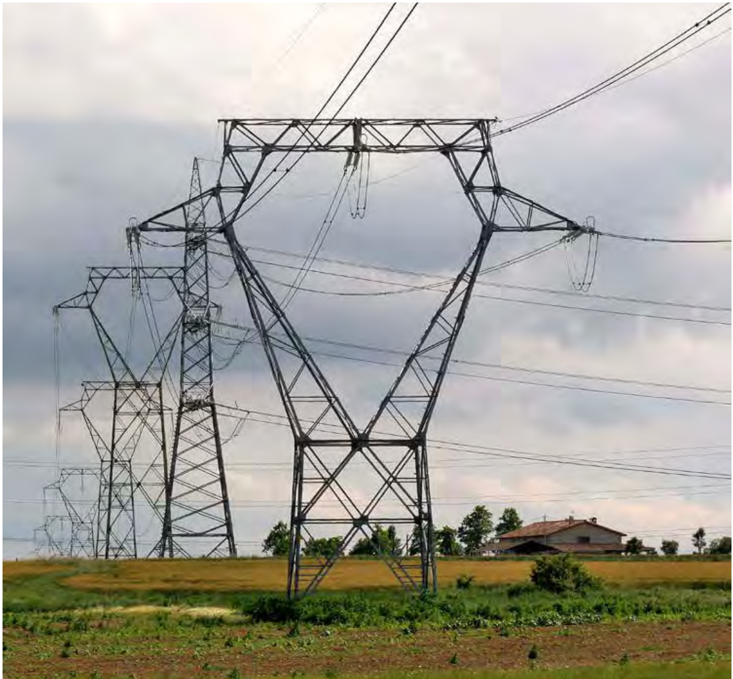
La construcció de torres d'alta tensió és una amenaça constant per al paisatge de les Comarques Centrals. Observatori del Paisatge
