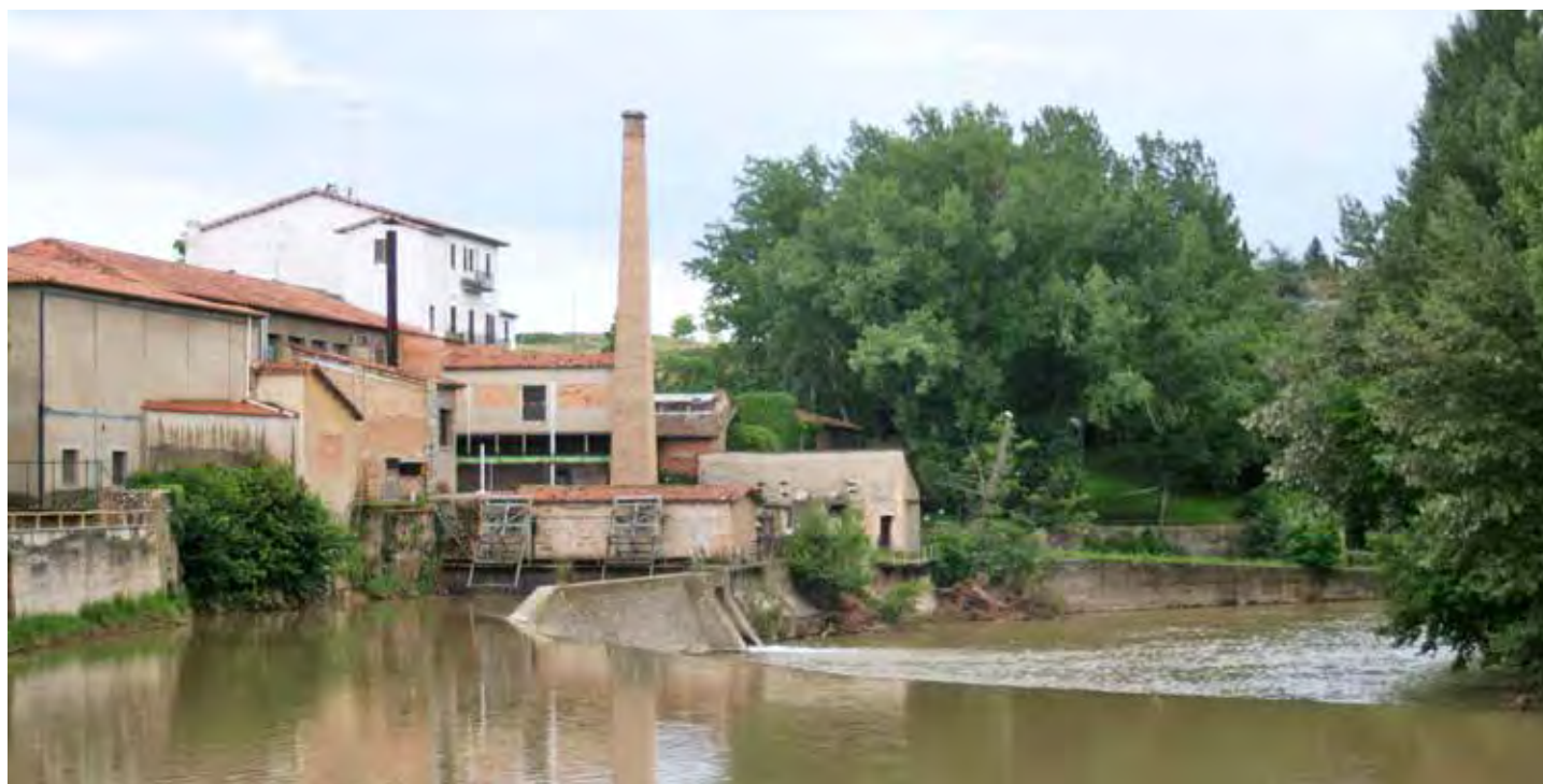
Resclosa i fàbrica de riu a Manlleu. Observatori del Paisatge
