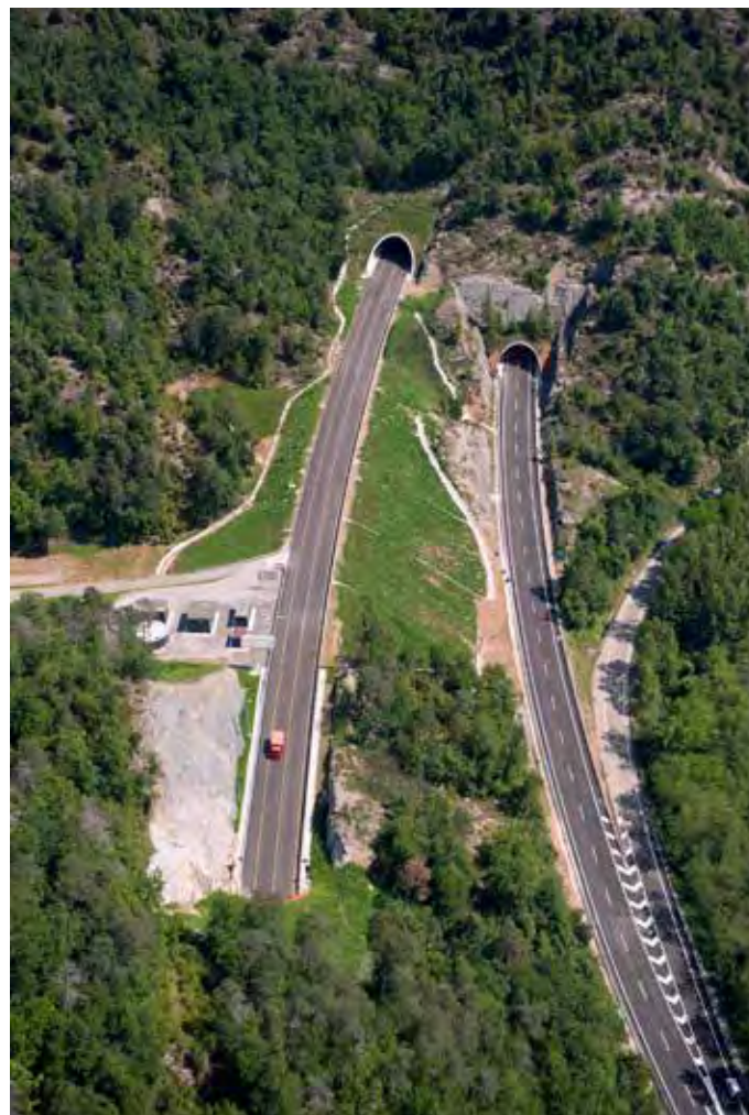
La construcció d'autovies ha comportat la realització de túnels i terraplens. Carretera C-17. Departament de Territori i Sostenibilitat
