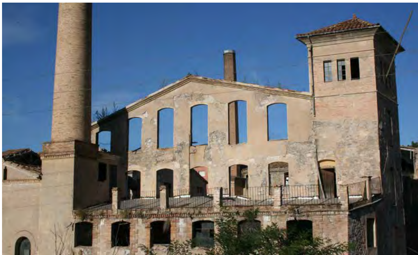
La Fabrica Vella de Sallent, una de les tèxtils més importants de les Comarques Centrals, destruïda per un incendi el 2006 després de més de vint anys d'abandó. Observatori del Paisatge
