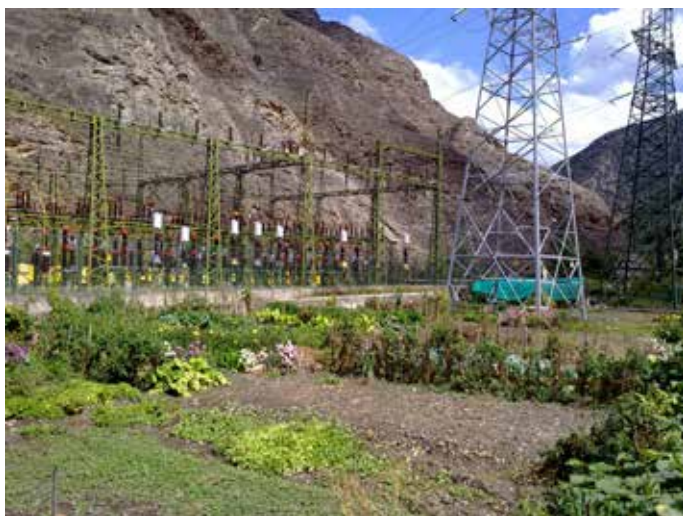
Algunes infraestructures elèctriques vinculades a la indústria hidroelèctrica, com les línies i les subestacions elèctriques, han alterat la imatge del paisatge. Observatori del Paisatge
