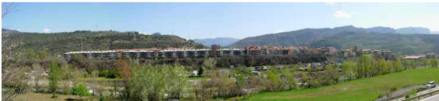
Façana urbana de la Poble de Segur des de la carretera que porta a Senterada. S'aprecia la homogeneïtat dels habitatges plurifamiliars discordants amb les tipologies constructives del casc antic del municipi. Observatori del Paisatge
