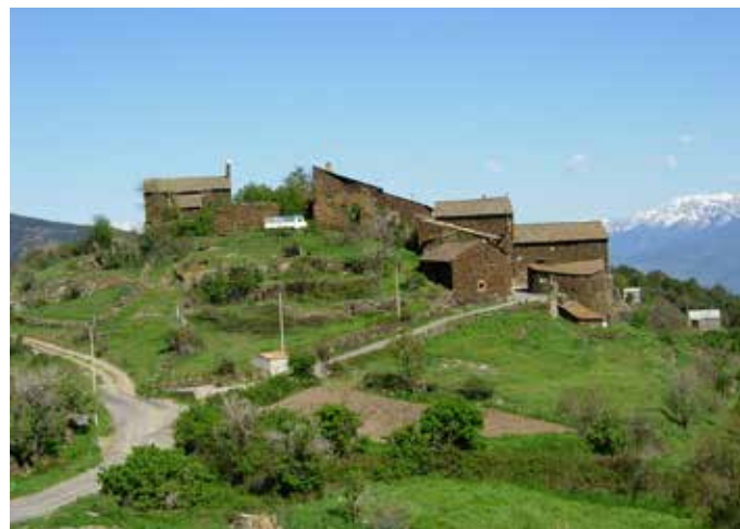
La vall de Castellbò amaga petits pobles d'arquitectura vernacular i poc alterada, com el de Santa Creu de Castellbò assentat dalt d'un petit turó que en condiciona la fesomia. Observatori del Paisatge
