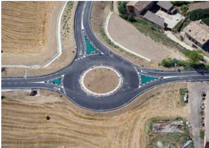
La construcció d'infraestructures de comunicació ha comportat una transformació significativa als fons de vall. A la imatge, fragment de la variant d'accés a Isona. Departament de la Vicepresidència i de Polítiques Digitals i Territori
