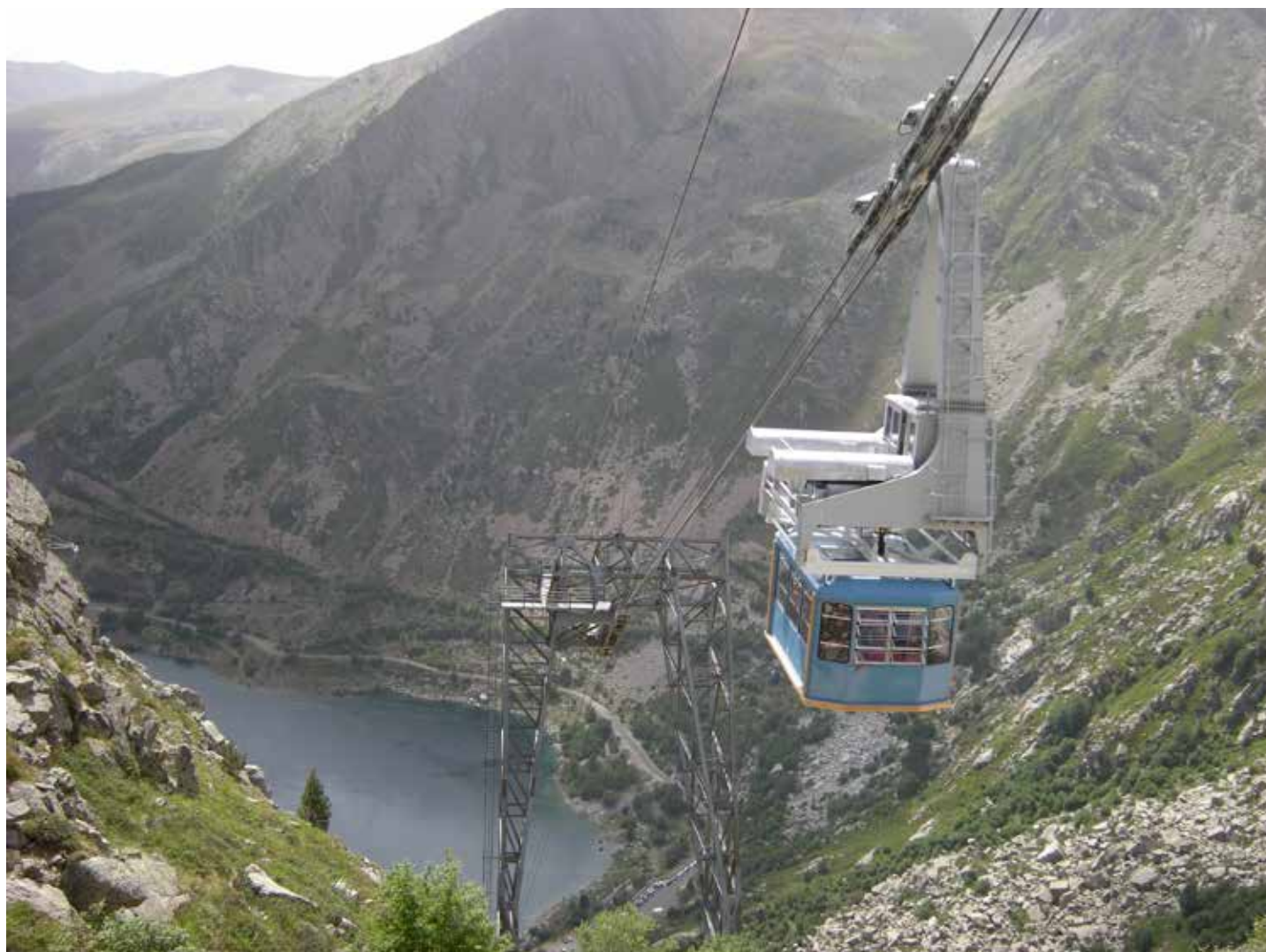
El telefèric Vall Fosca, instal·lat el 1989 per la construcció de la central reversible de Sallente, ara té un ús turístic i permet fer el trajecte entre Sallente i l'estany de Gento. Maria Dolors Oliveras
