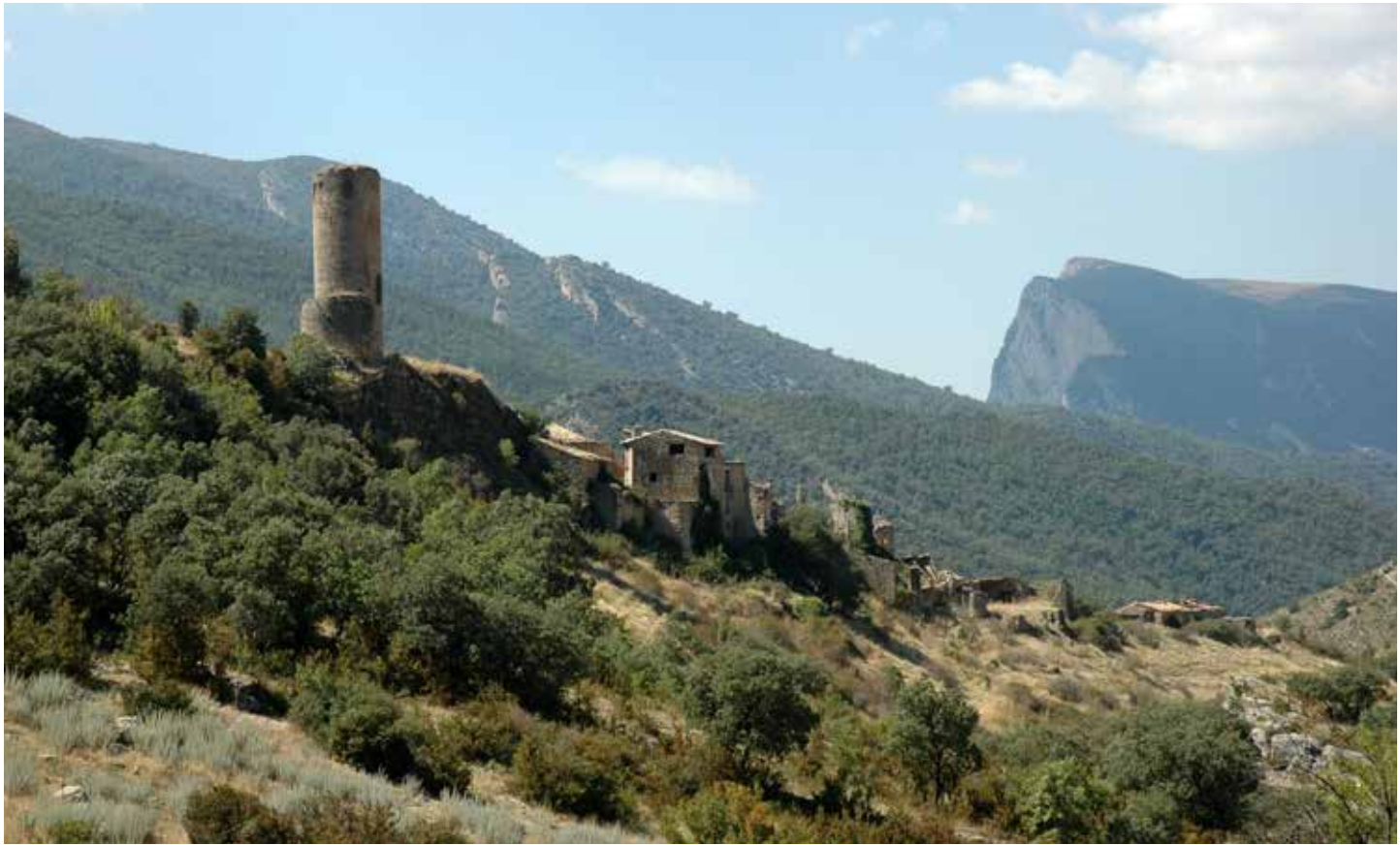
Cal evitar el deteriorament d'edificis singulars o nuclis històrics de gran interès patrimonial. A la imatge, el poble d'Alsamora, amb alguns edificis en ruïnes i la torre del segle XI restaurada. Josep Renalias
