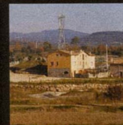
Construccions auxiliars de les masies
