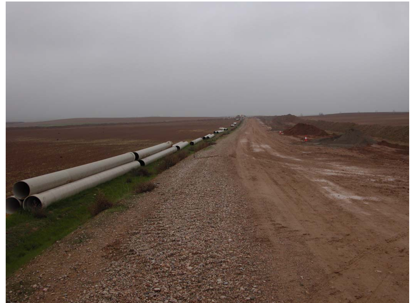
Fig.9.1. Obres d'ampliació de la zona regada pel canal Algerri-Balaguer, al camí d'Albesa a Castelló de Farfanya, al límit entre ambdós termes municipals. Vista al nord.
