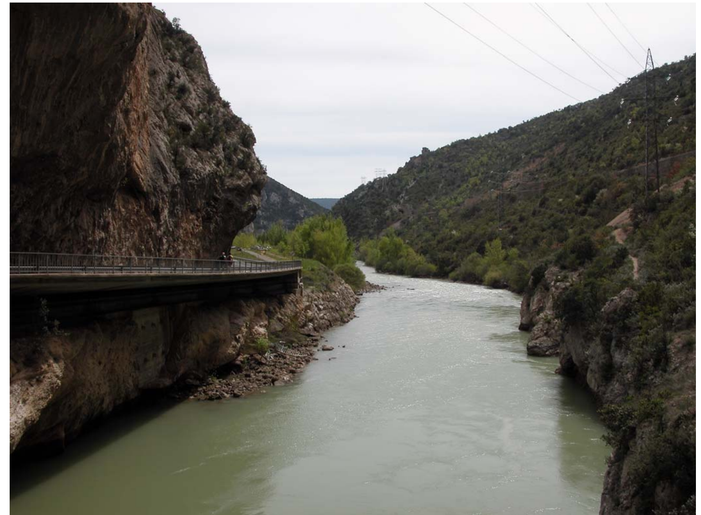
Fig. 9.6. Pas dels Terradets. Engorjat modelat pel riu Noguera Pallaresa. Panoràmica aigües avall del pont romànic. Carretera i línia elèctrica.
