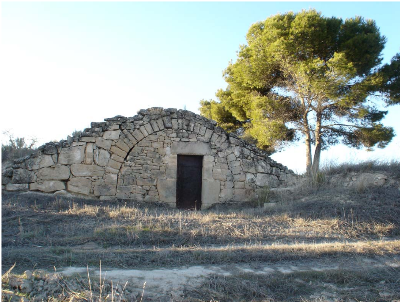
Fig. 7.7 Cabana de volta de pedra seca a la comarca de les Garrigues. Foto: O. Cornudella.
