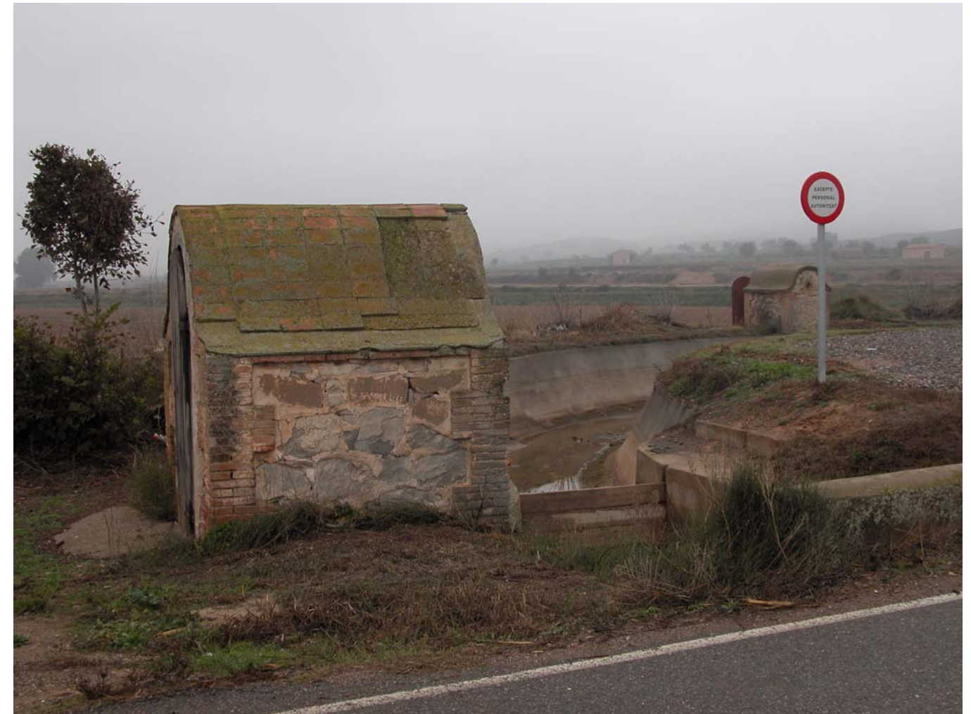
Fig. 7.9. Sèquia Primera del Canal d'Urgell, al nord de Bellcaire. Mòduls de regulació.
