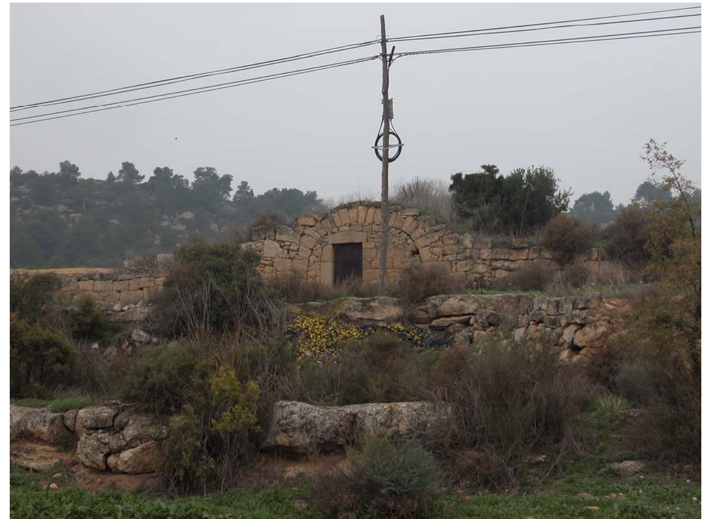
Fig. 4.4. Cabana de mitja volta al terme d'Esplugu Calba, a la vora de la carretera d'Omellons a l'Esplugu Calba.
