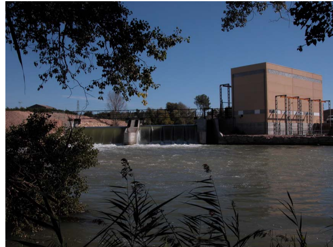
Fig. 4.6. Presa de Carratalà, que recull les aigües provinents del canal de Seròs abans d'unir-se amb les del Segre. Vista des del marge dret del riu Segre.
