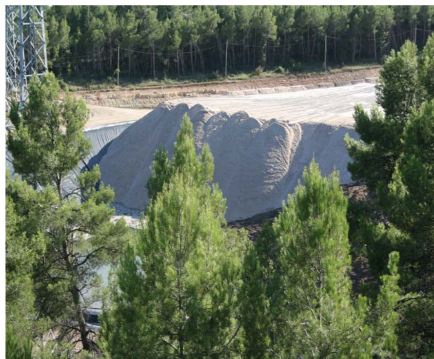
Figura 8.30 Treballs d'impermeabilització dels runams salins. Sallent.
