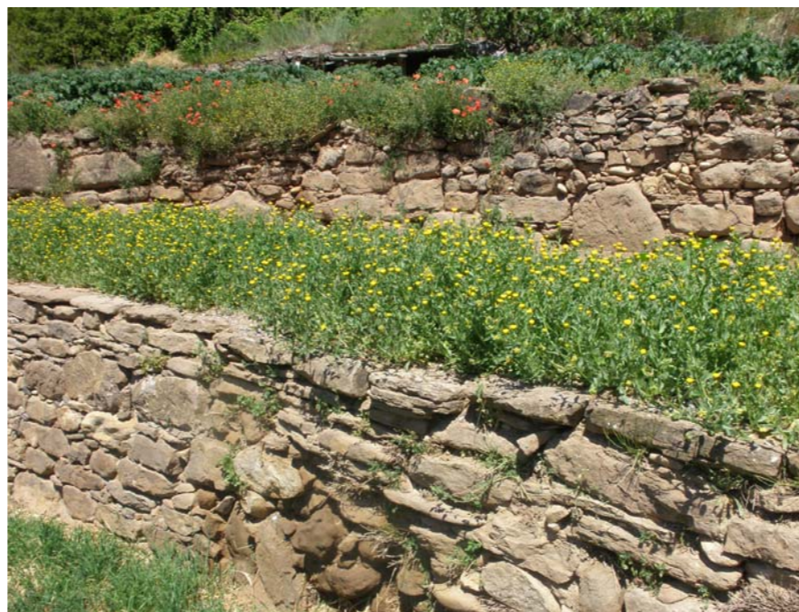
Figura 8.24 Murs de pedra seca a prop de Balsareny.
