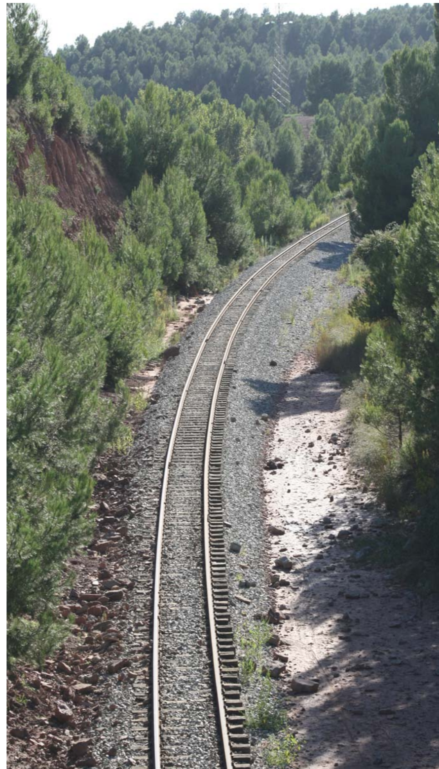
Figura 8.33. Els antics traçats ferroviaris estan rebent una creixent atenció. Per una part ja existeix l'experiència de l'Ecorail a Súria, i per altre s'estudia la seva reobertura per a servei de passatgers. Tram del FGC a Sallent.
