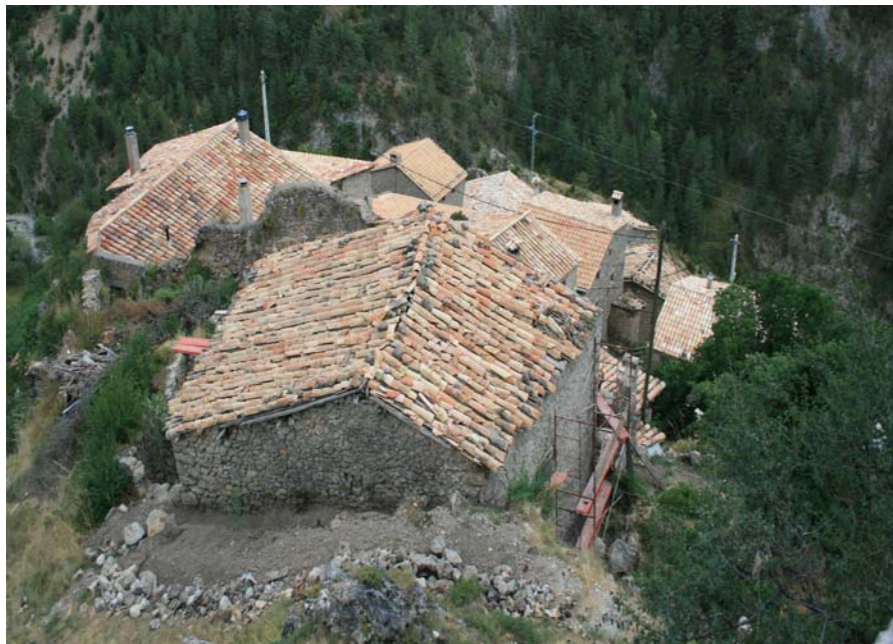
Figura 5.15 Casa en procés de restauració a Gósol.
