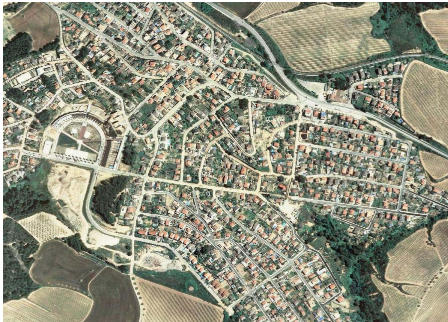
Figura 27.22 Urbanització de Can Bonastre, a Piera. Foto ICGC.
