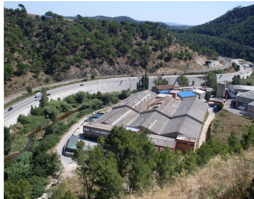
Figura 27.14 Polígon industrial instal·lat a la llera del riu Anoia, amb el conseqüent risc d'avinguda fluvial. Capellades.
