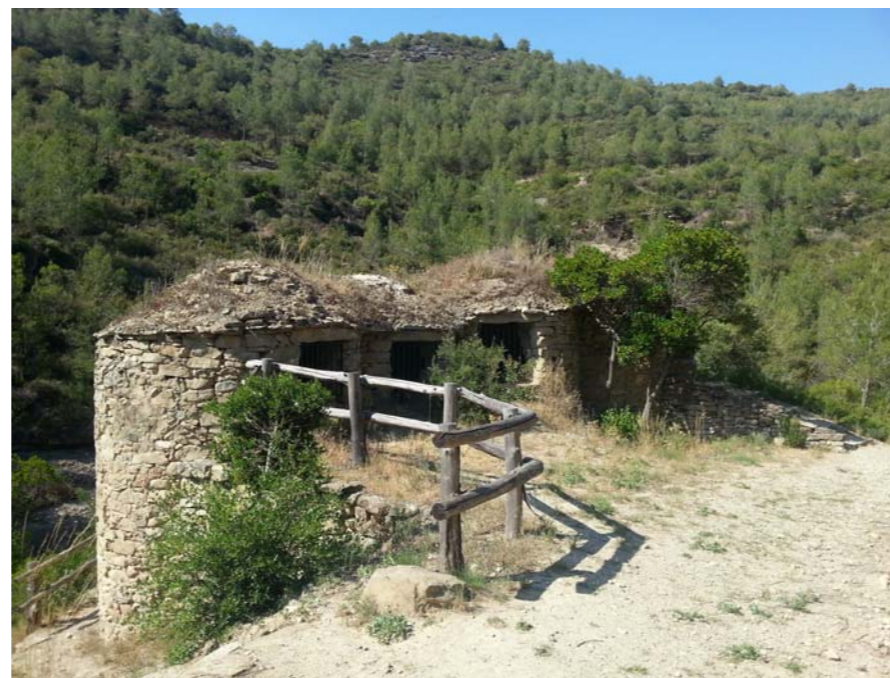
Figura 23.14 Les construccions de pedra seca, com aquestes tines, actualment se situen enmig de les masses boscoses de la unitat.
