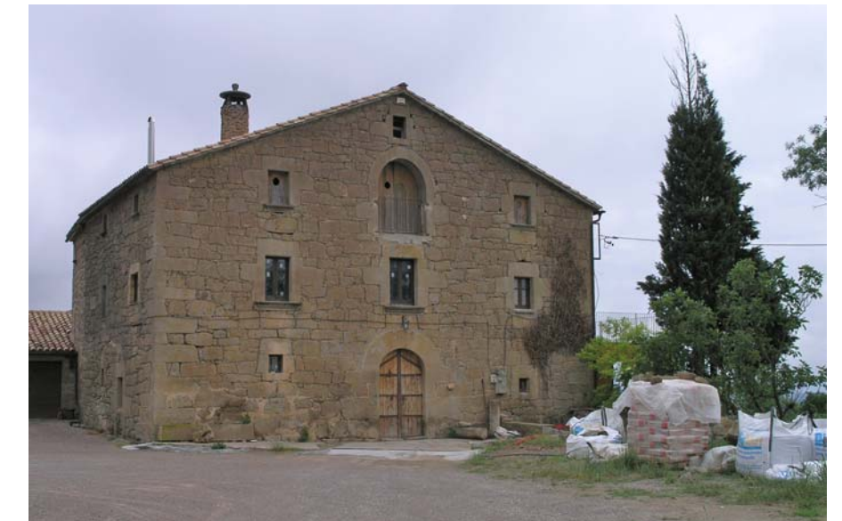
Figura 20.18 Masia en procés de rehabilitació. Llobera.
