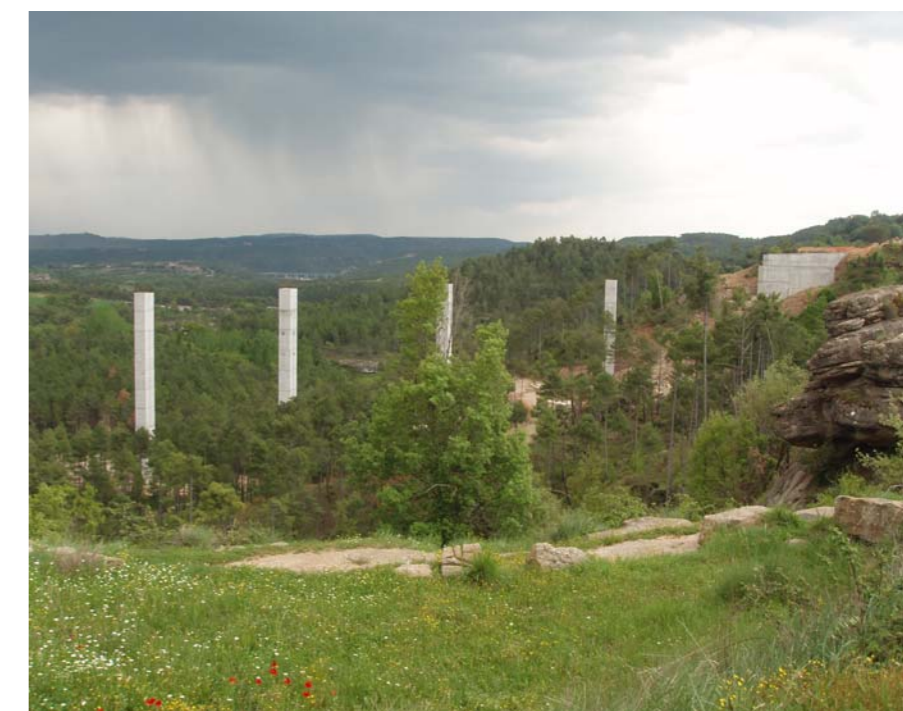
Figura 19.11 Construcció d'un viaducte de l'Eix del Llobregat. Casserres.
