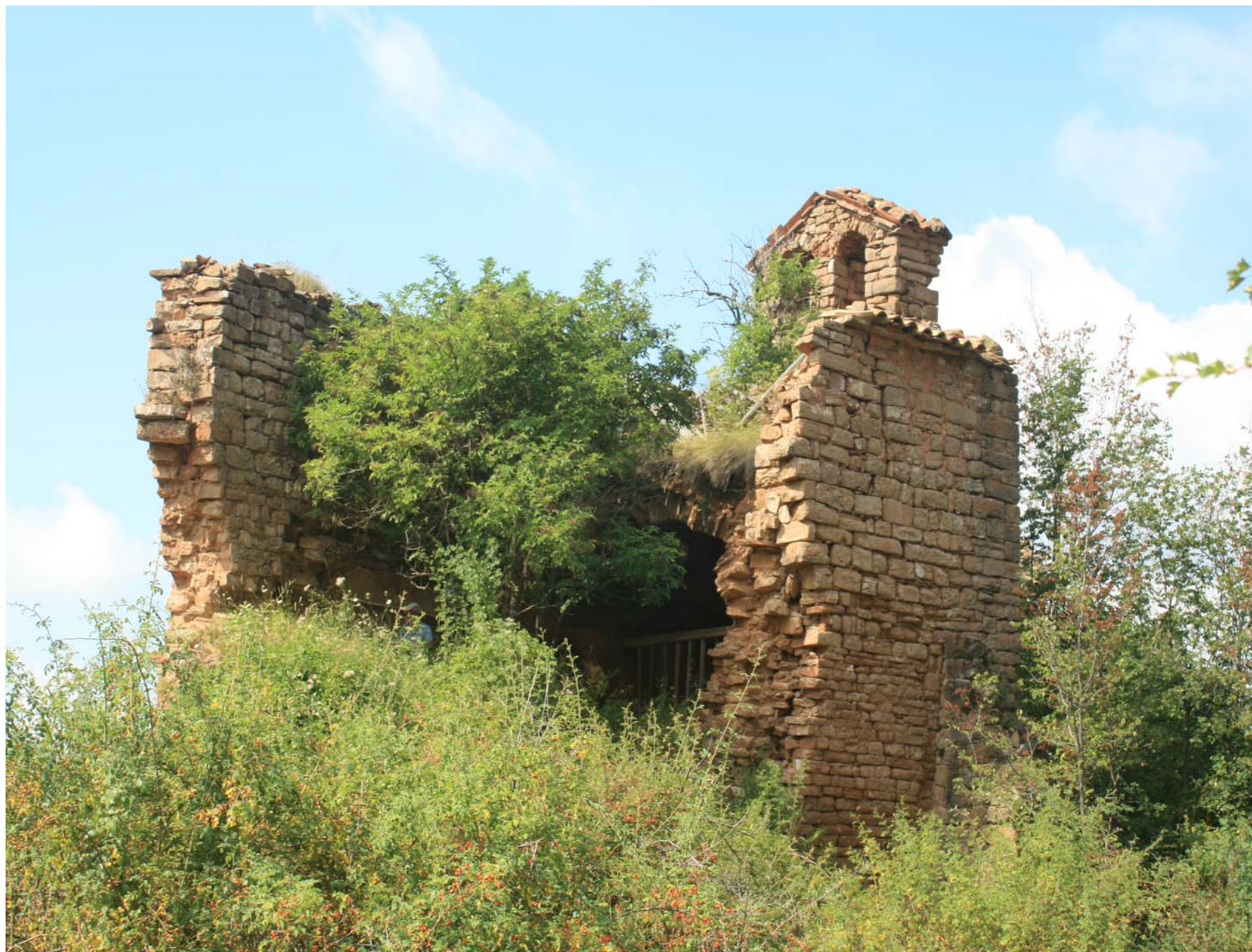
Figura 18.11 Llogaret de Bonner (Gósol), totalment abandonat amb l'església romànica de Santa Eulàlia de Bonner.
