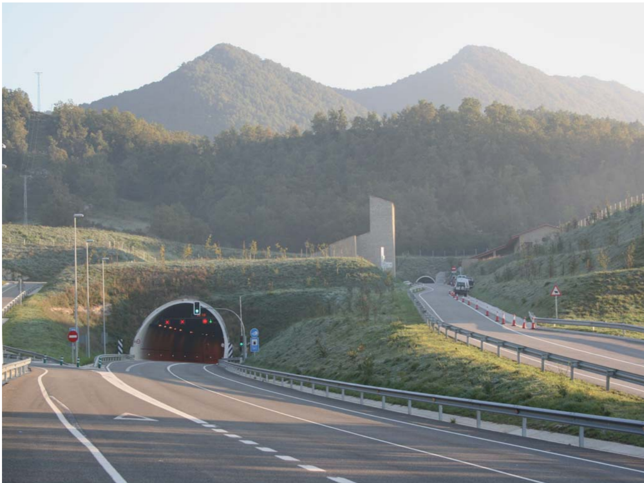
Figura 17.4 Les infraestructures tenen gran rellevància al paisatge de la Plana de Vic. Túnel de Bracons. Torelló.
