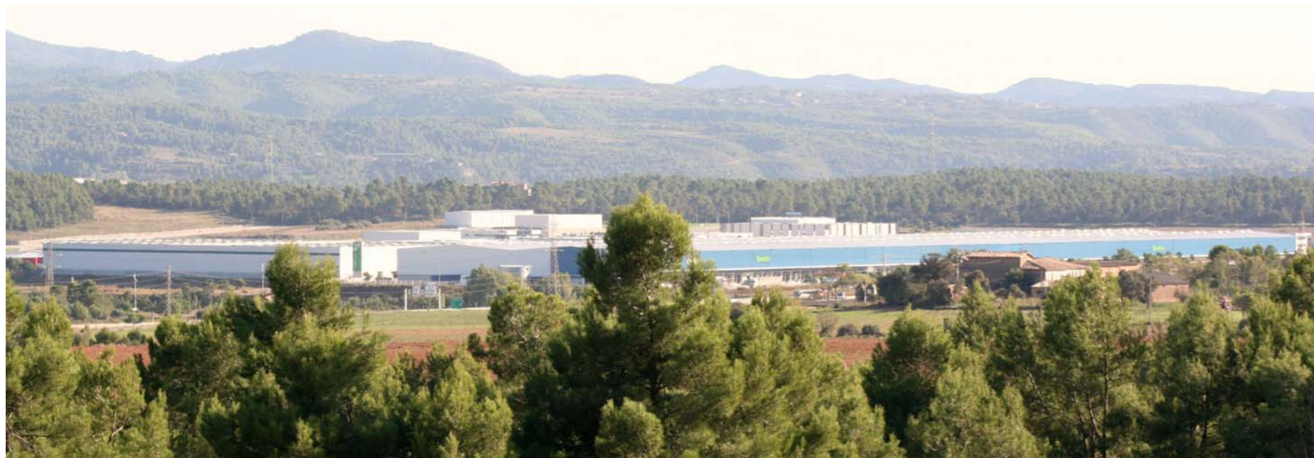
Figura 15.28 La xarxa de comunicació que ofereix el Pla de Bages ha propiciat la instal·lació d'empreses dedicades a la logística. Polígon Pla de la Sala-Logis Bages, Sallent, nau contínua de 53.000 m 2 .
