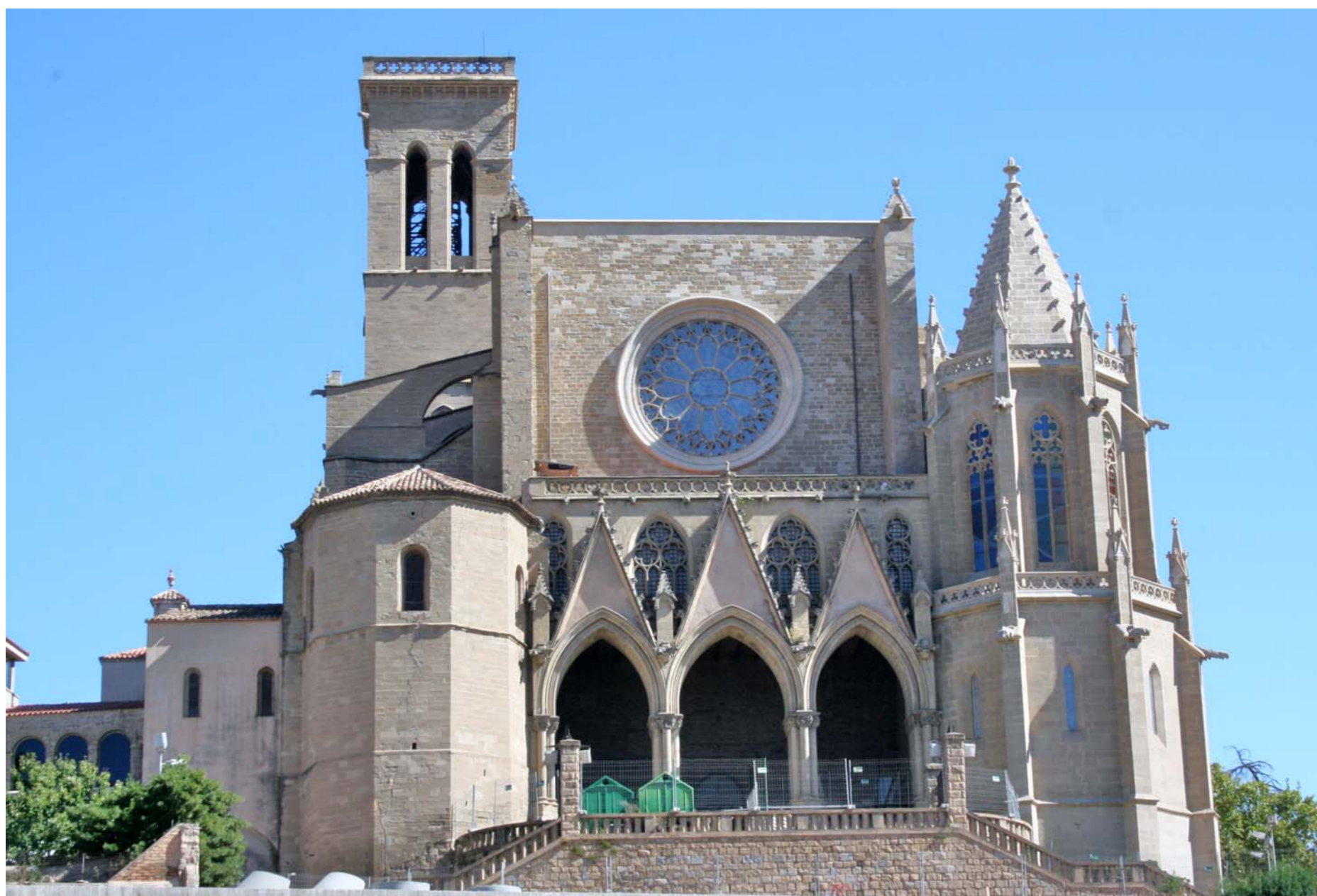
Figura 15.24 La Seu de Manresa, sobre el cim de l'antic Puigcardener, construcció gòtica assentada sobre altres restes més antics.
