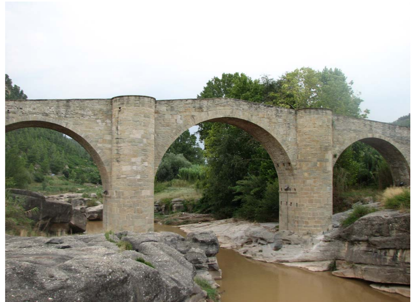
Figura 15.3 Tram central del Pont de Vilomara, obra gòtica de nou arcs i 130 m de llargària.
