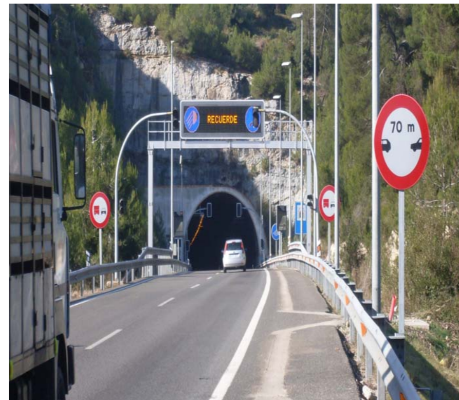
Figura 14.13 Boca d'entrada al túnel del Bruc, principal eix viari que travessa la unitat.
