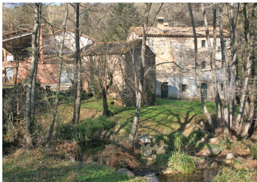
Figura 13.20 Instal·lacions del Molí Espatllat, a la riera de Font Savellà, a cavall del Montseny i les Guilleries.
