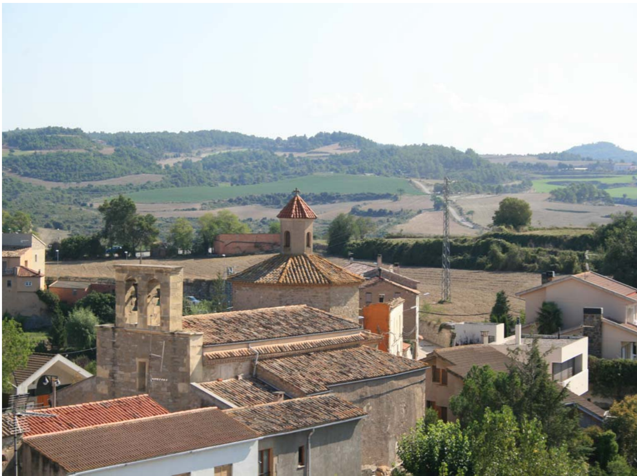
Figura 12.2 Vista parcial de Calders.
