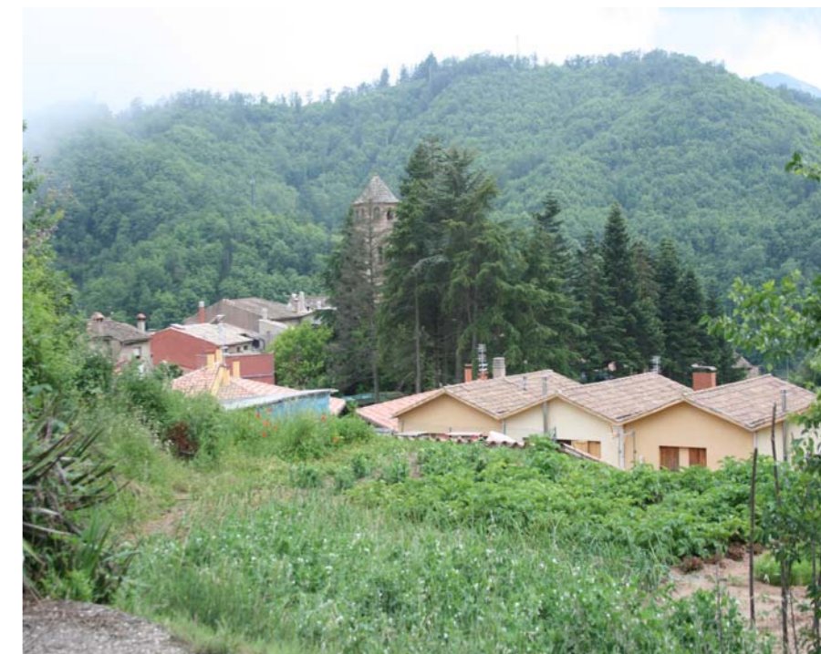
Figura 10.26 Nous habitatges a Espinelves.
