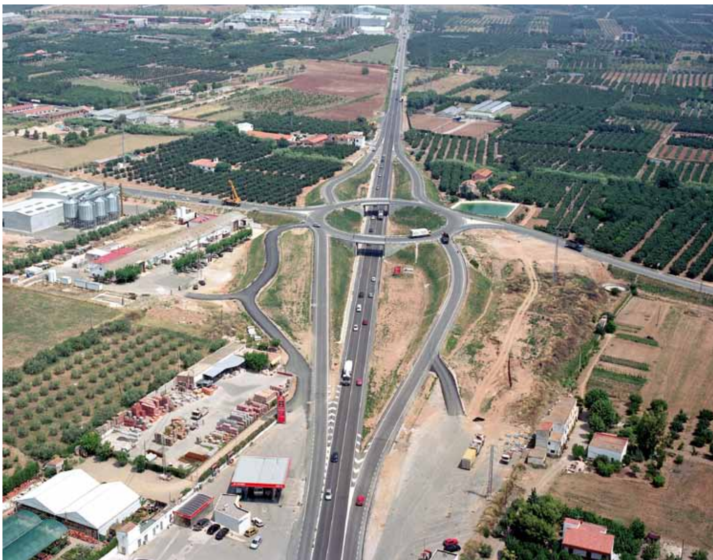
L'autovia C-14 a l'alçada de la Selva del Camp. Al seu voltant es poden observar algunes naus industrials i altres edificacions vinculades a l'ús agrícola dels Camps del Francolí. Departament de Territori i Sostenibilitat
