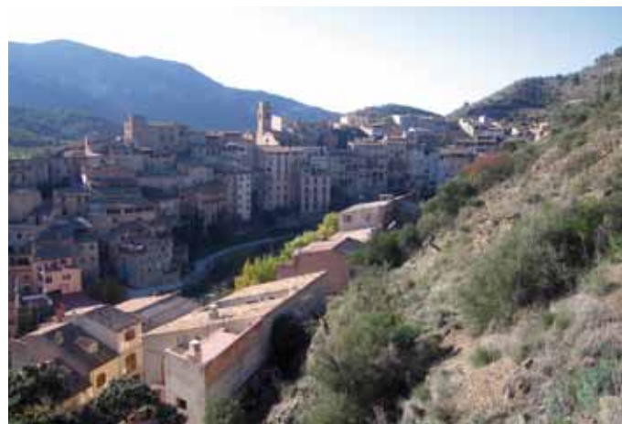
Les façanes d'alguns nuclis de població del Priorat Històric es conserven inalterades malgrat el pas del temps i tenen un alt valor patrimonial i arquitectònic, com la del nucli antic de la Vilella Baixa, que Josep Maria Espinàs va anomenar la “Nova York del Priorat”. Observatori del Paisatge
