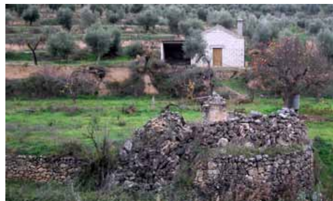
L'expansió del conreu de l'olivera va implicar la construcció de murs de pedra seca i altres construccions de pedra seca auxiliars com sínies, cabanes i camins, algunes amb bon estat de conservació que d'altres. Actualment conviuen amb noves construccions, de vegades poc integrades en l'entorn. Observatori del Paisatge
