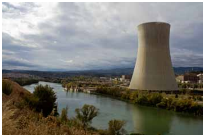
Torre de refrigeració del complex nuclear d'Ascó. Cristina Sabaté, Escola d'Art i Disseny de Tarragona
