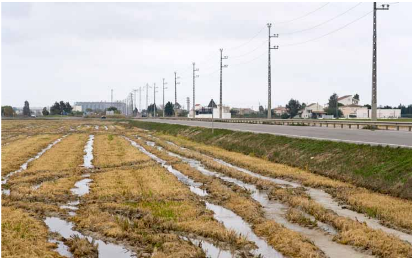
Algunes línies elèctriques aprofiten el traçat de les carreteres ja existents. Lluís Vives, Escola d'Art i Disseny de Tarragona
