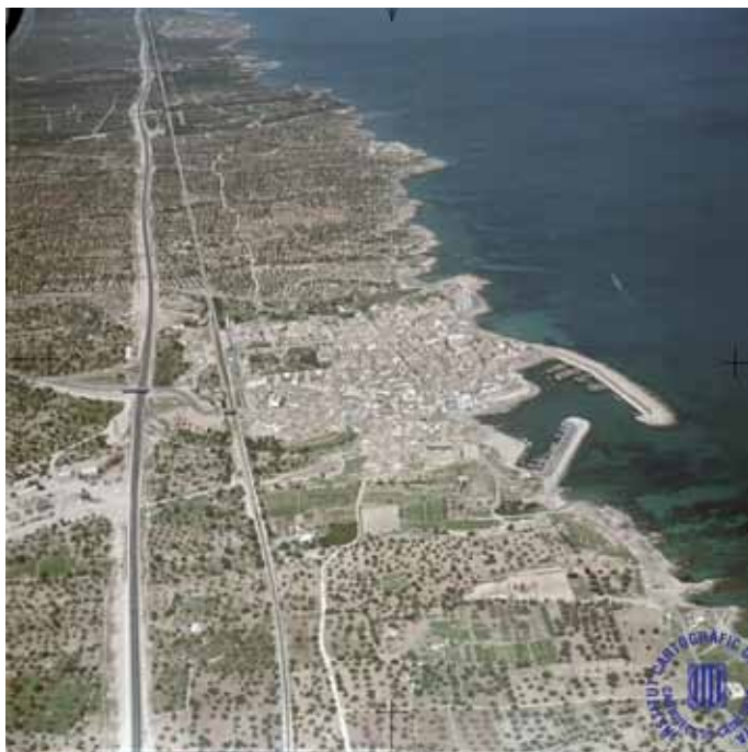
El litoral del Baix Ebre fou un dels paisatges on tingué més incidència la construcció de l'autopista AP-7, com es pot apreciar en aquesta imatge del procés de construcció. ICC, Fons SACE
