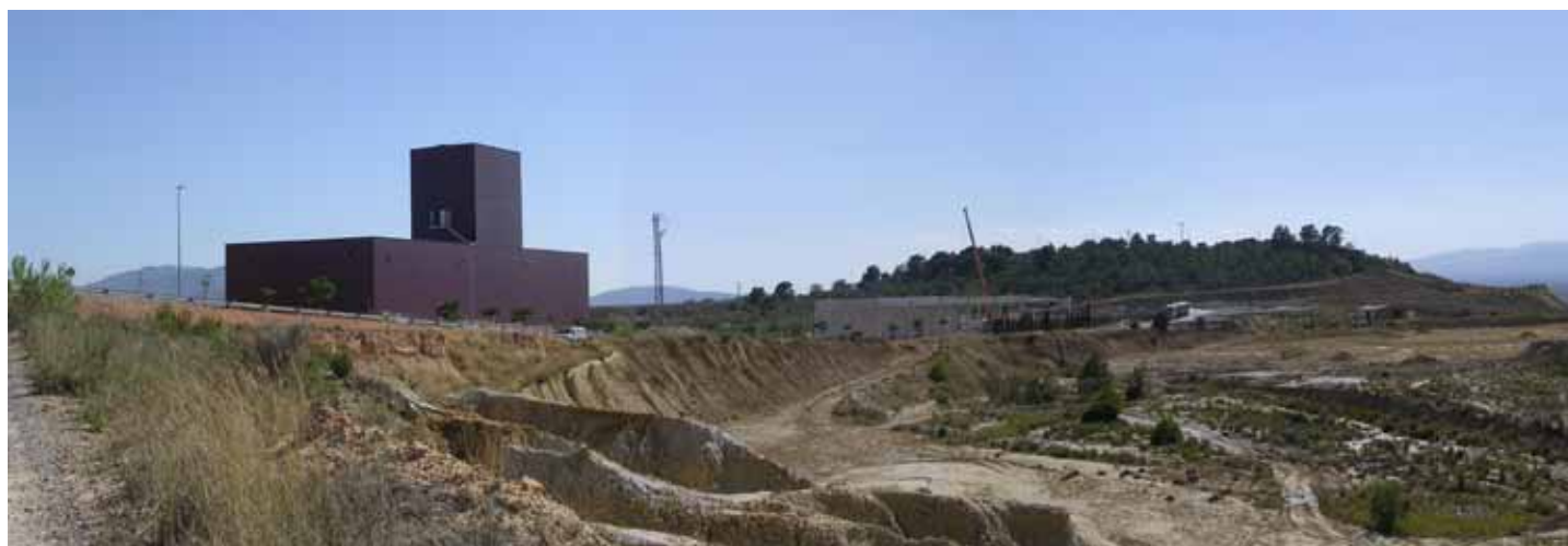
Hi ha la previsió que el polígon Catalunya Sud, actualment amb un nivell baix d'ocupació, sigui la superfície industrial més gran de les Terres de l'Ebre. Observatori del Paisatge
