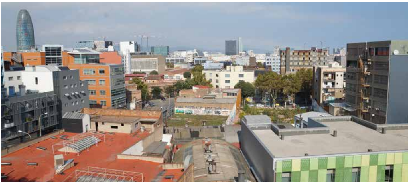
Al Poblenou, en el marc del projecte 22@, s'està donant un procés de canvi d'usos i de renovació de l'edificació. Observatori del Paisatge
