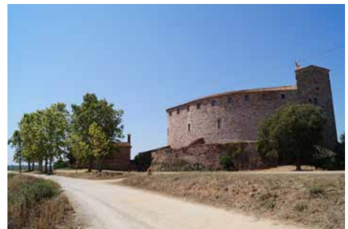
El castell de Sentmenat és un edifici de pedra obert a la banda de ponent i tancat per la banda de llevant per un gros mur que tenia l'objectiu de protegir l'edifici per la part més fàcilment accessible. Observatori del Paisatge
