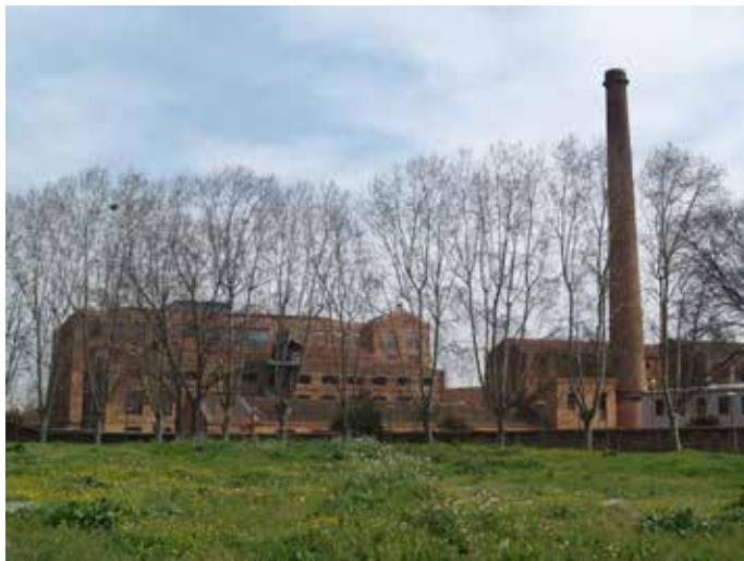
Les edificacions de la Colònia Güell (Santa Coloma de Cervelló) tenen la capacitat d'evocar els orígens del paisatge industrial de la Regió Metropolitana de Barcelona. Josep Padró
