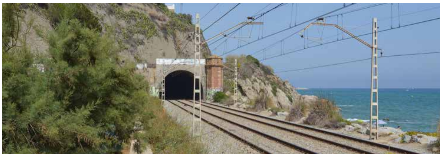
La via del tren Barcelona-Maçanet transcorre per la plataforma litoral al llarg de tota la unitat, fet que suposa una barrera física i visual. Observatori del Paisatge
