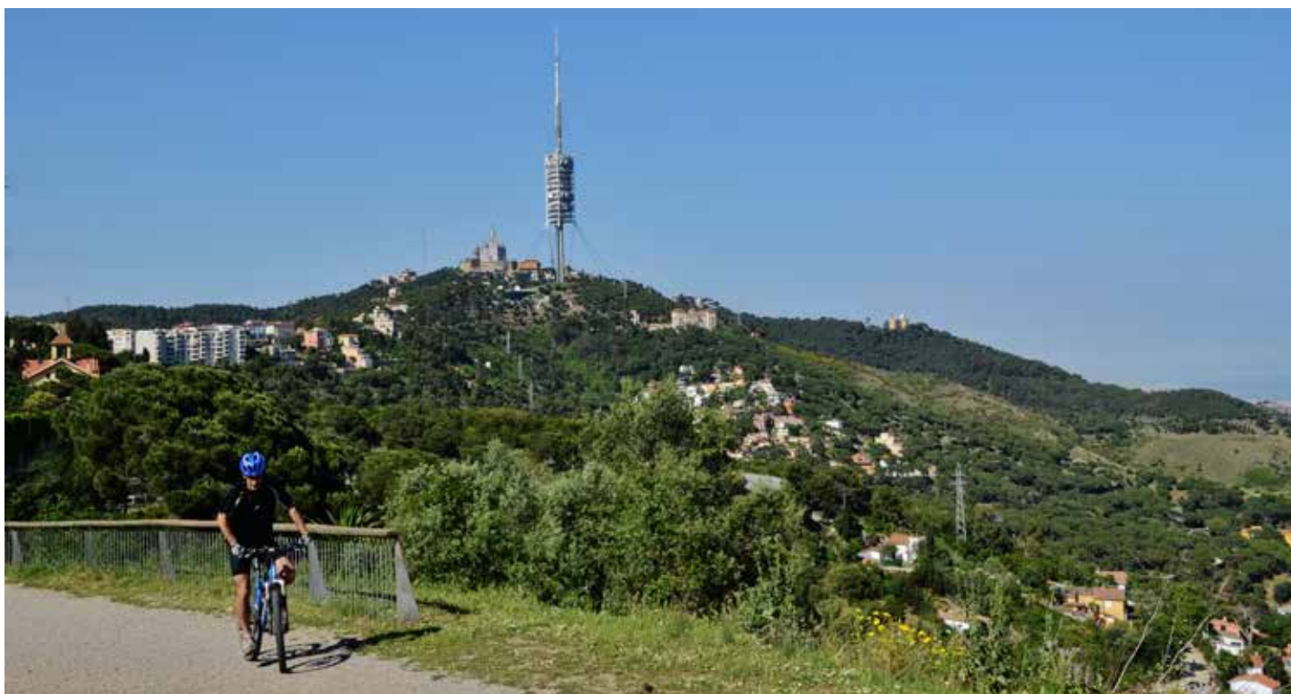
La torre de Collserola i el temple del Sagrat Cor són edificacions emblemàtiques de la unitat. Maria Rosa Ferré
