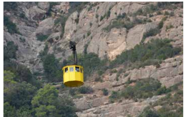
L'Aeri de Montserrat, inaugurat el 1930, comunica l'estació de l'Aeri de Montserrat amb el Monestir amb un desnivell de 544 metres. Harvey Barrison
