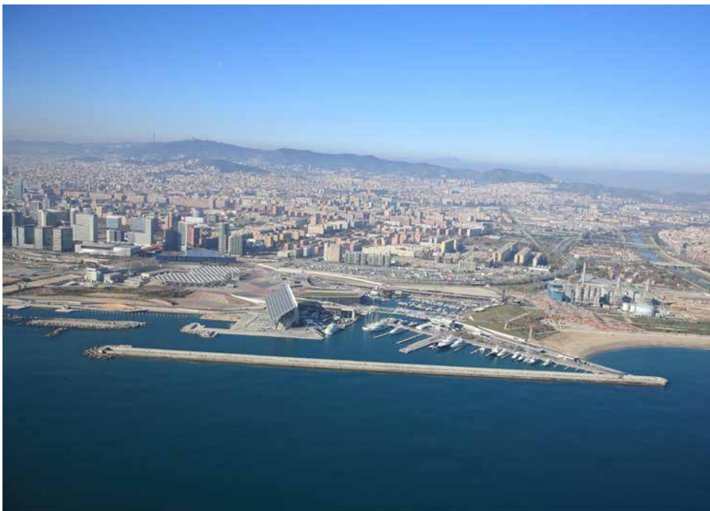
La reforma urbanística prèvia al Fòrum Universal de les Cultures 2004 va comportar la posada en valor de la desembocadura del riu Besòs, entre Barcelona i Sant Adrià del Besòs. Departament de Territori i Sostenibilitat
