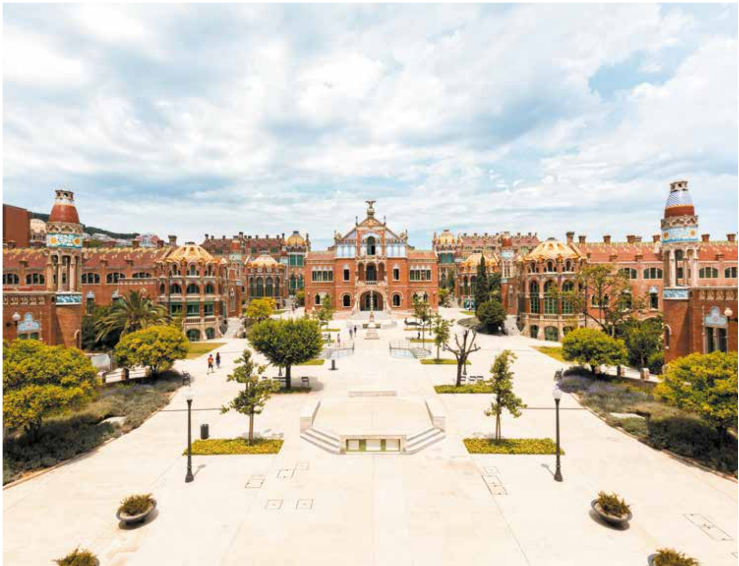
El conjunt modernista de l'Hospital de la Santa Creu i Sant Pau, projectat per l'arquitecte Lluís Domènech i Montaner, és Patrimoni de la Humanitat per la UNESCO per la seva singularitat constructiva i bellesa artística. Turisme de Barcelona
