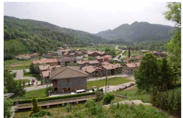
Nucli urbà de Llanars, amb els nous creixements al fons de la vall. Observatori del Paisatge
