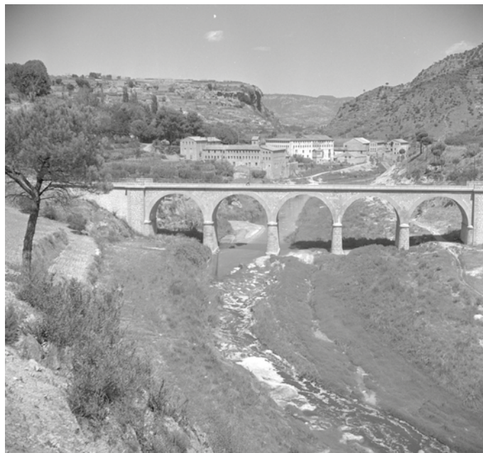
Pont sobre el riu Anoia a mitjan segle xx on es poden apreciar les edificacions vinculades amb la indústria paperera. ICGC, Fons Cuyàs
