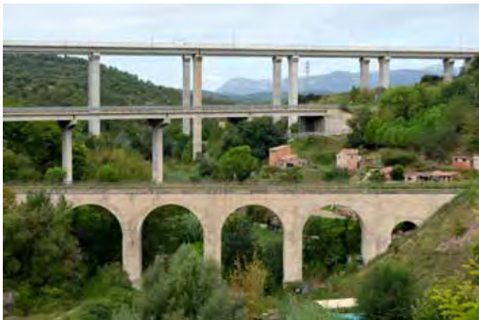
Vista des de la colònia tèxtil de Viladomiu Nou (Gironella) cap a la riera de Clarà (Casserres). De baix a dalt trobem el viaducte de l'antic Carrilet, l'antiga carretera C-1411, el viaducte de la nova C-1411 i finalment el viaducte de l'autovia C-16. A baix en primer terme barraques d'horta i al fons la serra de Travil (Prepirineu). Arxiu d'imatges de l'Observatori del Paisatge de Catalunya (Carles Vico Blanco)
