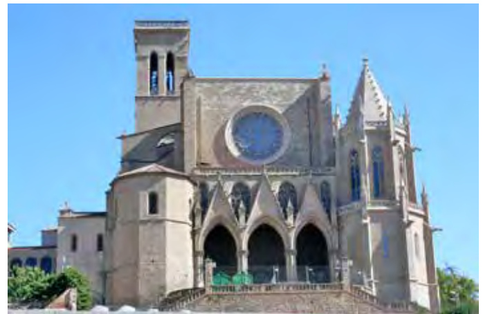
La Seu de Manresa, sobre el cim de l'antic Puigcardener, construcció gòtica assentada sobre altres restes més antigues. Observatori del Paisatge
