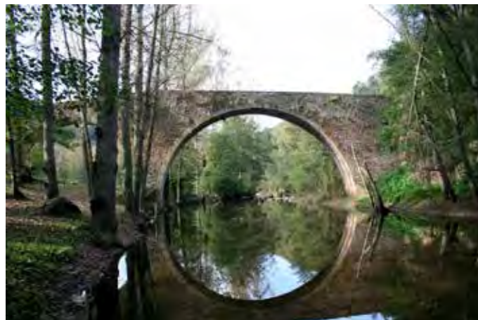
Els ponts són infraestructures vinculades des d'antic als paisatges fluvials, com el pont de Malafogassa a Vilanova de Sau. Observatori del Paisatge
