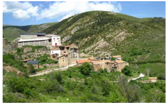
La construcció d'edificacions sense mesures d'integració paisatgística és una amenaça per aquest paisatge. A la imatge, granja que altera el perfil tradicional del nucli els Castells (Valls d'Aguilar). Observatori del Paisatge
