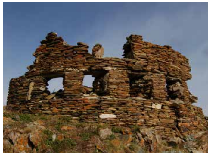
Restes de construccions defensives del front del Pallars de la Guerra Civil espanyola a les carenes de la serra d'Aurati, entre la vall de Cardós i la vall d'Àneu. Observatori del Paisatge
