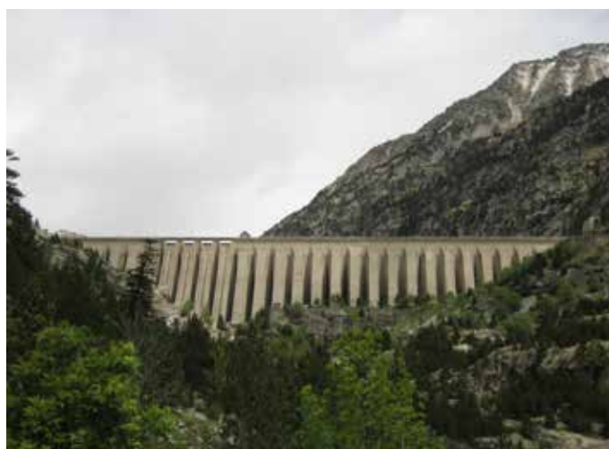
La presa de Cavallers, a la ribera de Caldes, és segurament la infraestructura que causa més impacte visual de per tota la unitat. Observatori del Paisatge
