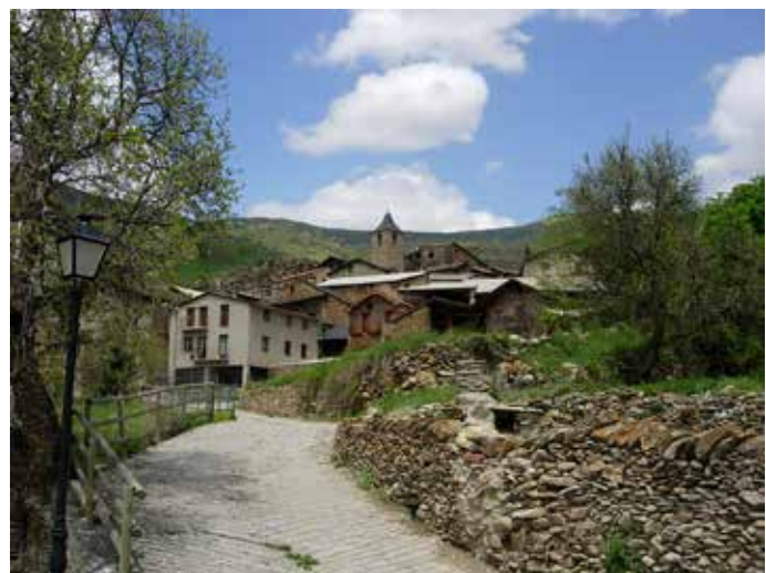
L'abandonament de l'activitat agrícola és patent en pobles com Bescaran, on el pas del temps va deteriorant els murs de pedra seca tan característics del lloc. Observatori del Paisatge
