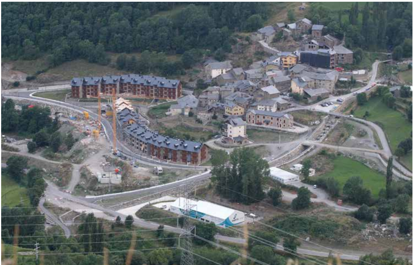
Noves construccions al nucli d'Espui, a la vall Fosca, que alteren la seva fesomia tradicional i distorsionen el clar límit entre l'espai construït i l'espai obert que hi sol haver en els nuclis petits i compactes del Pirineu. Observatori del Paisatge
