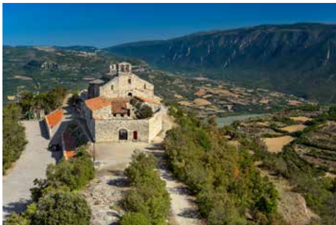
L'església de Santa Maria de Mur és un dels edificis més emblemàtics del conjunt arquitectònic de Mur, que domina tota la Conca de Tremp fins a l'estret de Terradets. Jorge Franganillo
