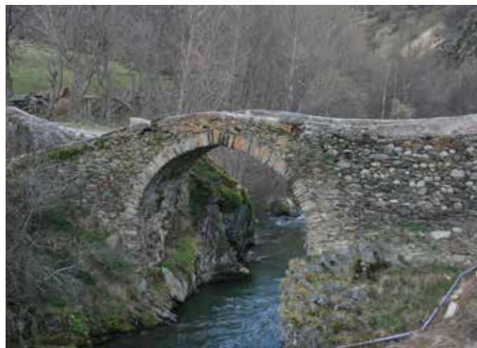
Un dels diversos ponts antics que creuen la Noguera de Cardós, en una zona amb una densitat única al Pirineu català de construccions civils d'aquest estil. Observatori del Paisatge
